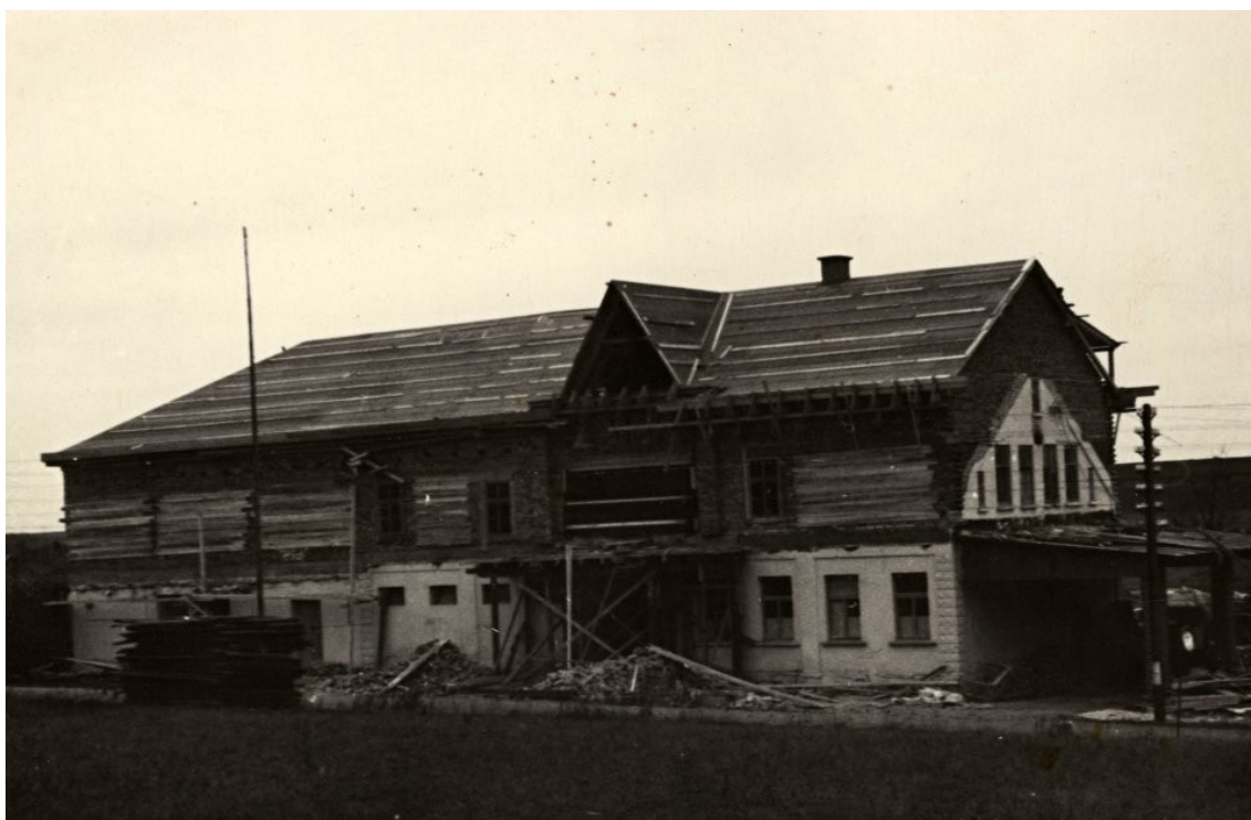
Budova bývalé betonárky během přestavby na „leteckou školu“. Dnes je budova neobývaná, v havarijním stavu a na prodej. Ze soukromého archivu pana Jaroslava Plachty, s jeho laskavým svolením.
