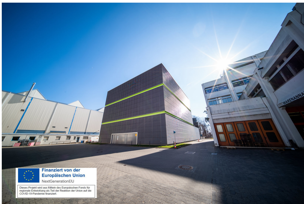
Obrázek 2.2: Fotografie datového centra Green IT Cube, Administrativní budova GSI je viditelná vpravo. Obrázek byl převzat z webových stránek GSI [17].
