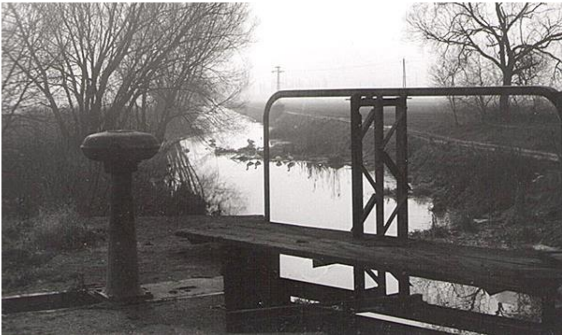
Obrázek 4 – Stav Baťova kanálu v roce 1989 [7]
