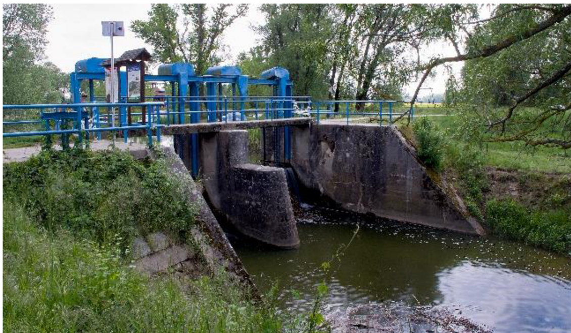
Obrázek 5 – Stávající jezová konstrukce Rohatec s lávkou [17]
