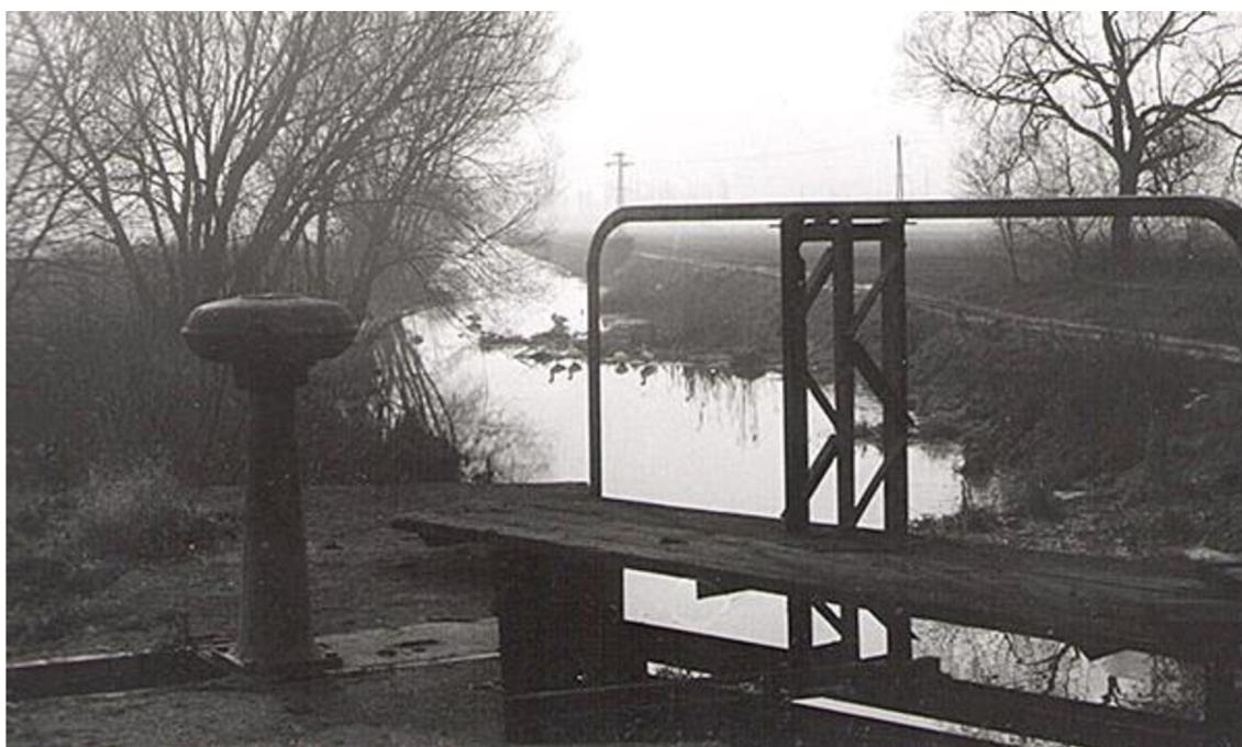
Obrázek 4 – Stav Baťova kanálu v roce 1989 [7]
