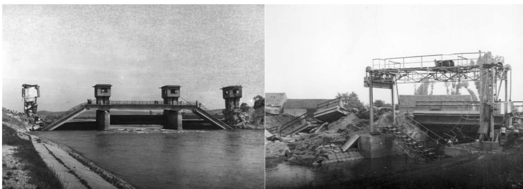
Obrázek 3 – Devastace plavebního kanálu po ústupu německých vojsk [7]
