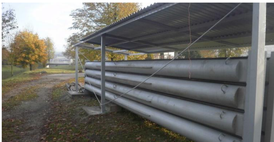
Obrázek 13 – stojan provizorního hrazení na jezu Salm, Blansko [16]
