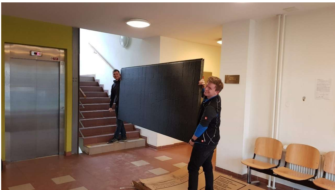
Obrázek 4: Přesun desek CLIMAVER NETO do laboratoře ústavu technických zařízení budov
