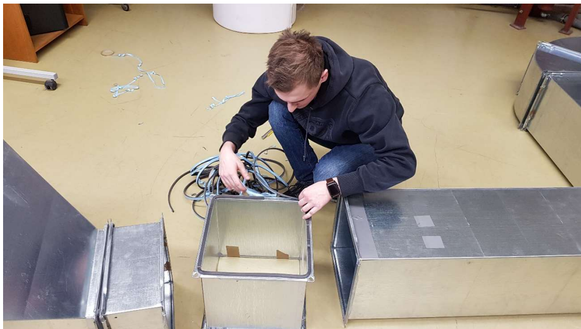
Obrázek 6: Montáž ocelového potrubí
