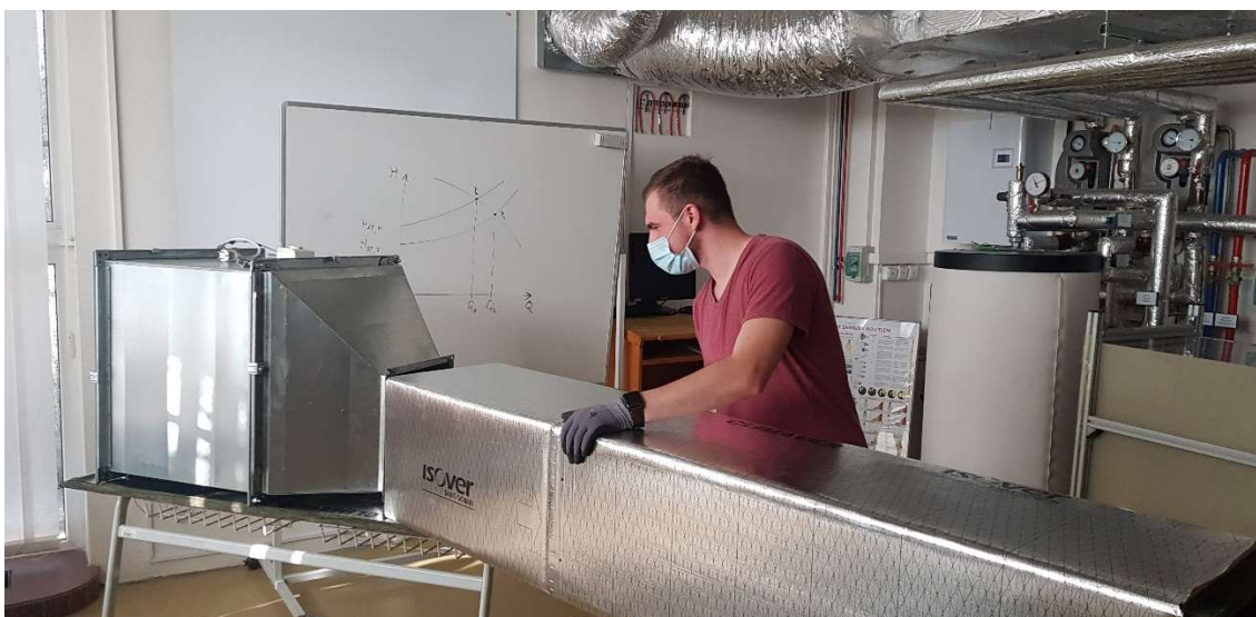
Obrázek 5: Montáž potrubí CLIMAVER
