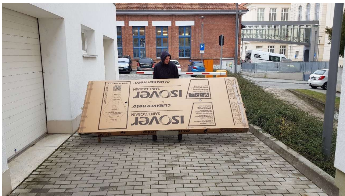
Obrázek 3: Doprava materiálu pro skládání potrubní trasy
