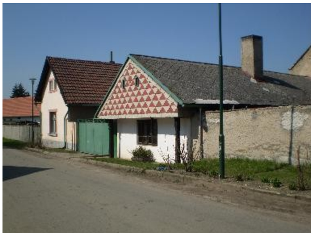
Obr.4 Obytný dům č.2. Dům s podsíní, štít je vynášen dvěma sloupy. Má sdružená okna.
