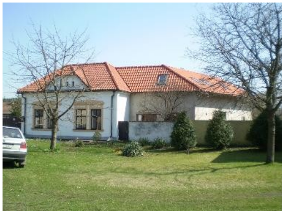
Obr. 19 Dům č. 10, s rozšířeným průčelím a novými přístavbami.
