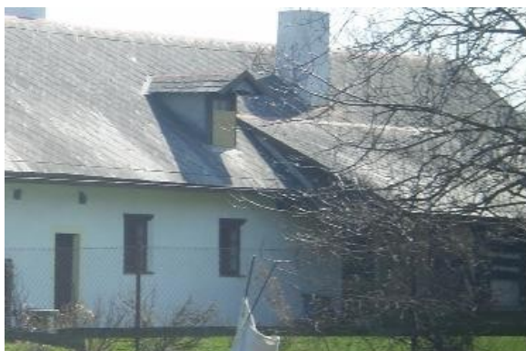
Obr. 6 Zadní strana domu č. 4, vlevo je vidět roubení.
