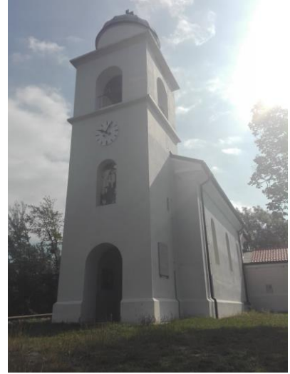
Kostel zasvěcený Panně Marii na vrcholu Mengore
