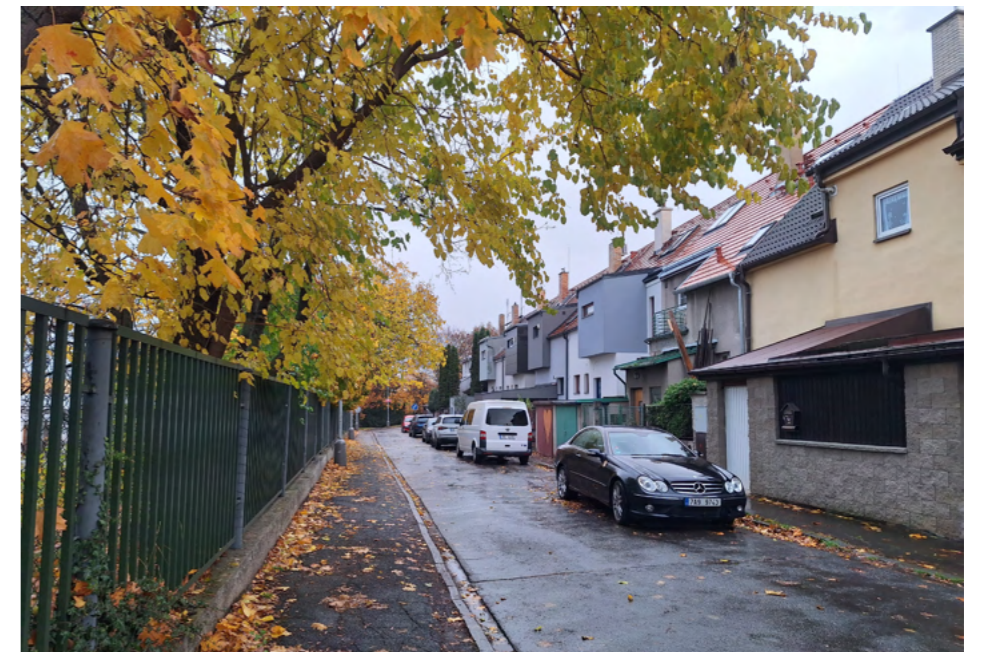
Obr. 58 Nevzhledné přístavby prvního poschodí opakující se v řadové zástavbě, někde i přístavba nevhodného zádveří, v popředí barevně nevhodná střešní krytina
