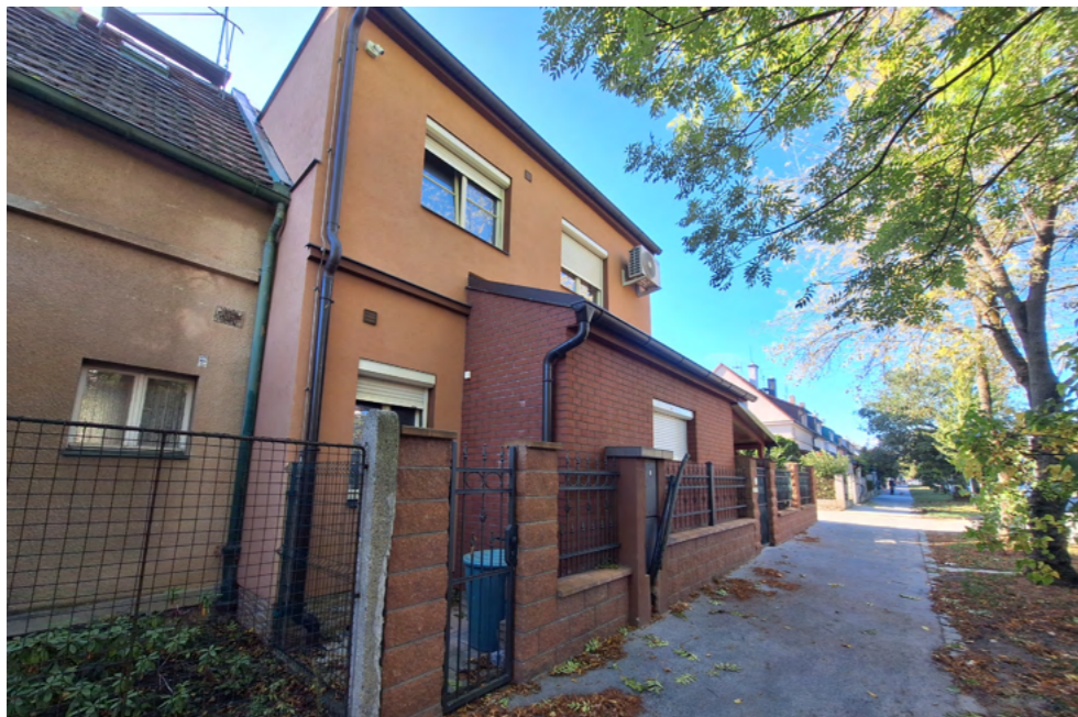
Obr. 56 Přístavba domu do výšky i směrem do ulice s přidáním neprůhledným zádveřím a nadbytečným plotem navíc, vše v nevhodných barvách
