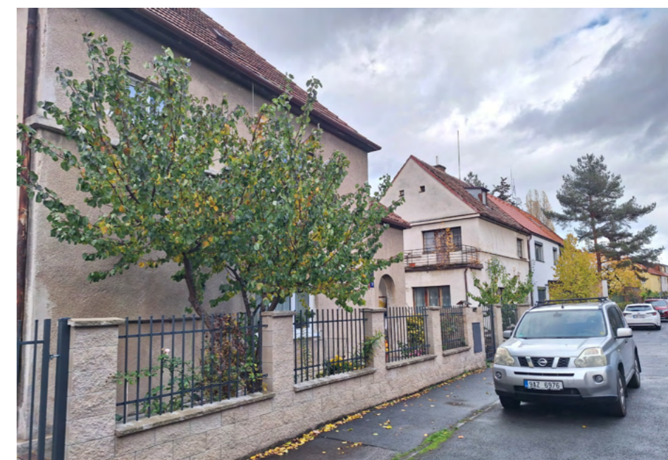
Obr. 88 Poměrně vhodná alternativní varianta oplocení dodržující hmotovou podsadu původních plotů, materiál podsady mohl být zvolen vhodněji
