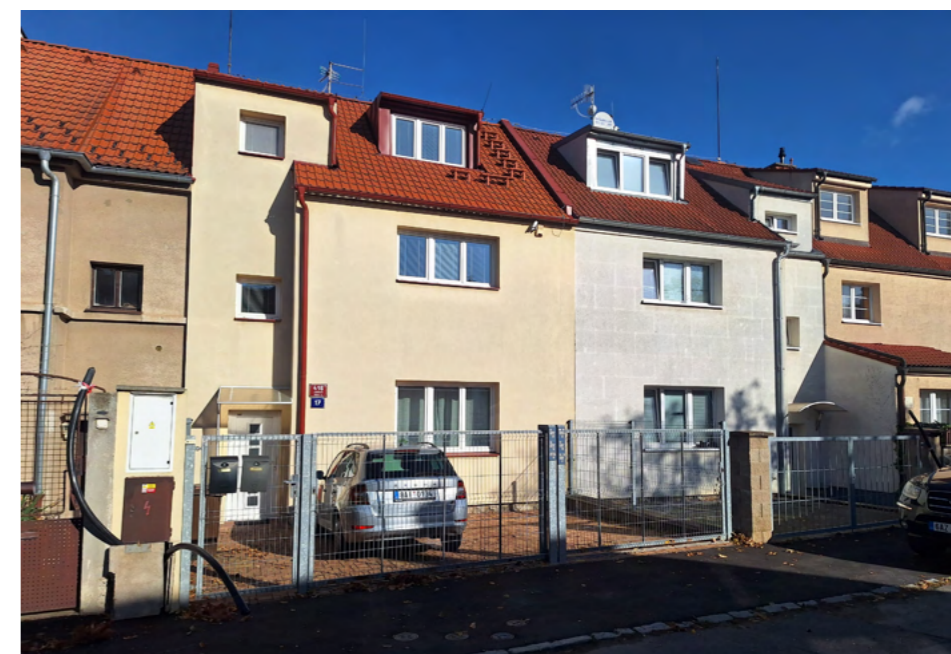
Obr. 128 Zde předzahrádka kompletně ustoupila holé vydlážděné parkovací ploše
