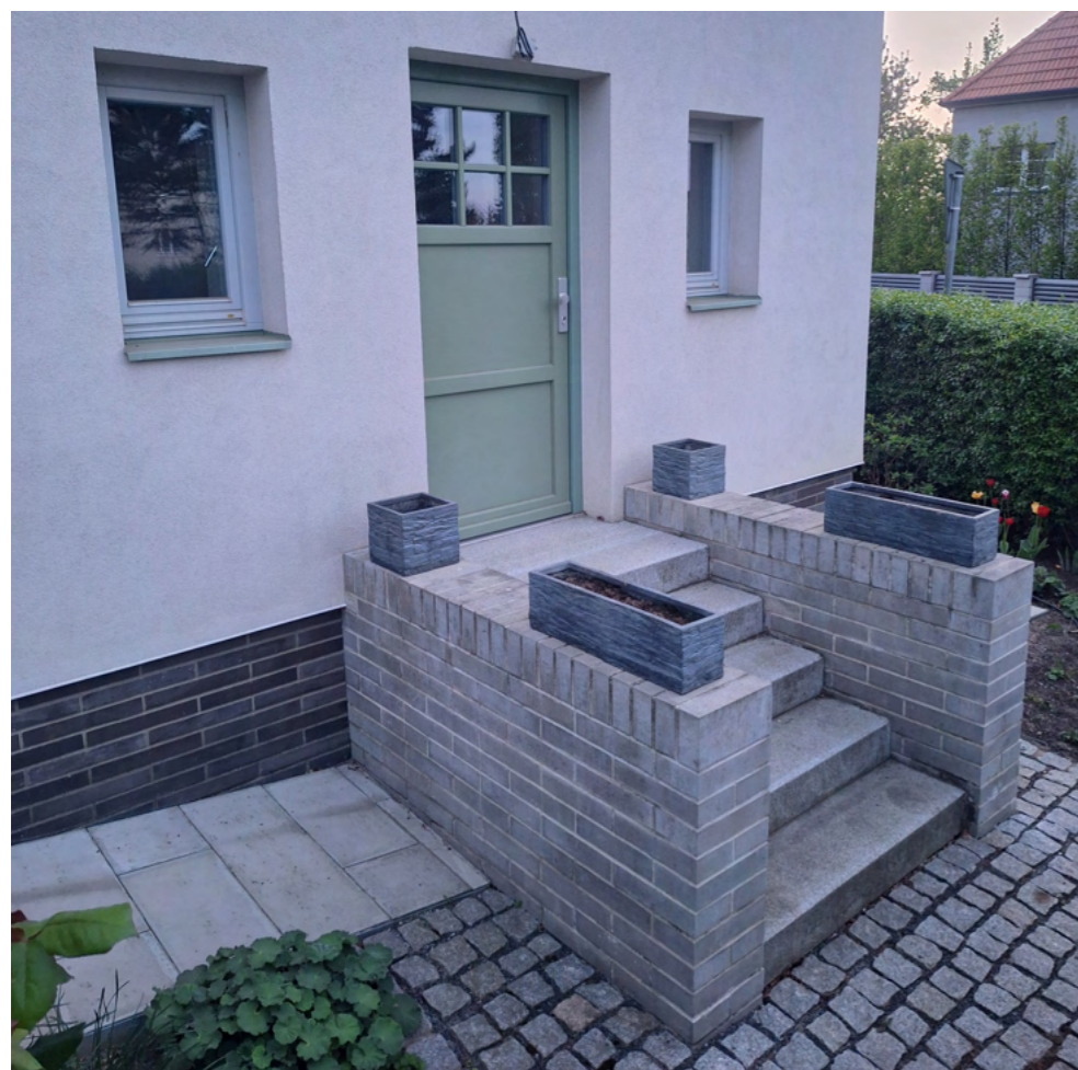
Obr. 126 Zdařená rekonstrukce předzahrádky včetně povrchů, schodů a vchodových dveří
