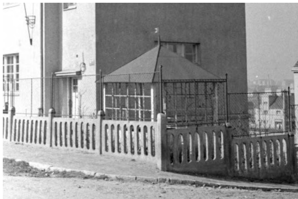
Obr. 75 Původní nízké oplocení nastavené kovovým pletivem s oky
