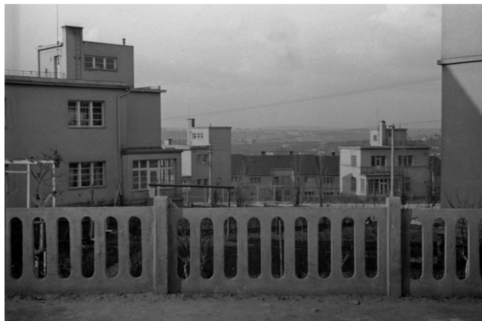
Obr. 73 Detail původního oplocení
