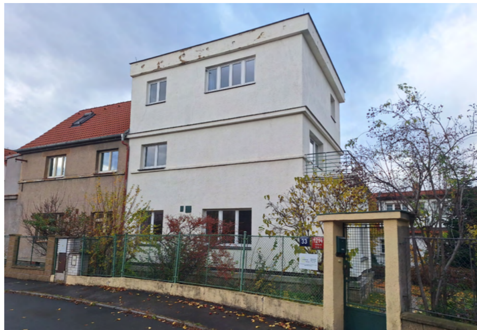
Obr. 57 Přístavba vyhnaná do výšky, zrušení původní sedlové střechy a nahrazení střechou plochou; zároveň příklad poměrně vhodné alternativy oplocení
