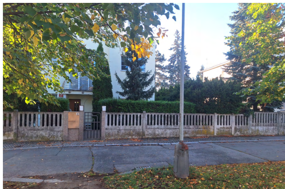
Obr. 80 Celistvá betonová podstava původního plotu
