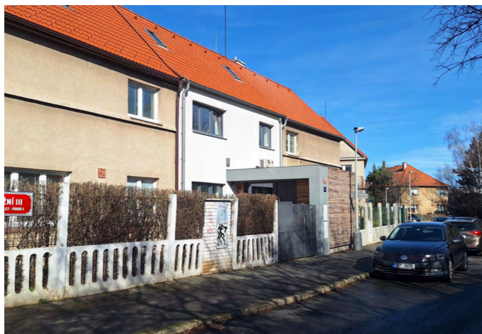
Obr. 63 Přistavěné zádveří nevhodné hmotově i materiálově, vyhlazení členěné fasády domu
