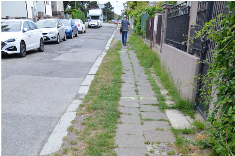
Obr. 110 Původní částečné dláždění - v současnosti revitalizované (viz obr. 111)
