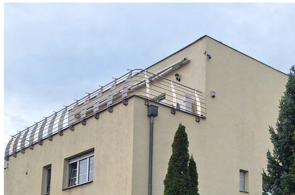
Obr. 130 Snaha o zachování podstaty podoby zábradlí při jeho výměně
