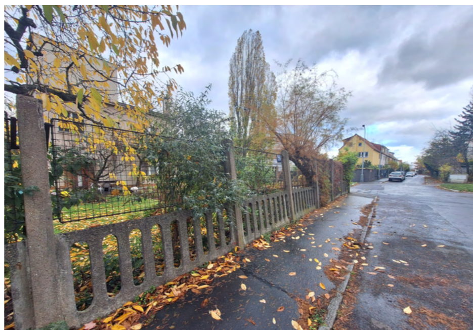
Obr. 78 Vyvýšené betonové sloupky vyplněné kovovým pletivem
