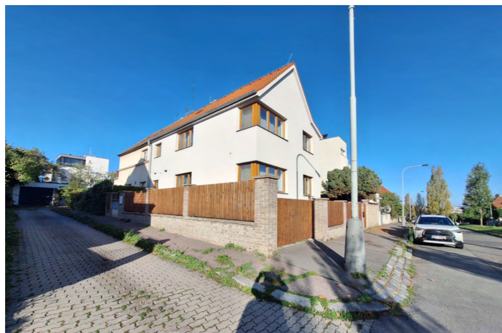
Obr. 59 Vyhlazení členěné fasády zateplením, výrazně barevné okenní rámy, změněný tvar oken
