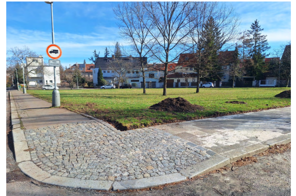
Obr. 112 Část zrekonstruovaného chodníku na Východním náměstí
