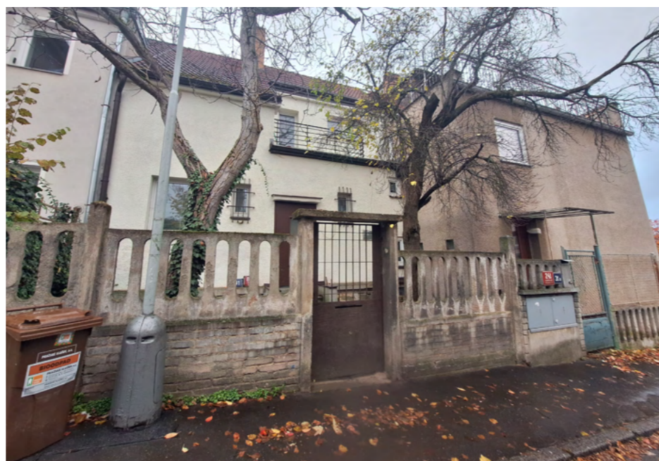
Obr. 81 Obměna betonu v podstavě za betonové cihly
