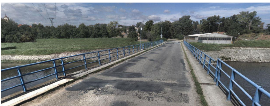
Obr. 11) Silniční most Rajhradice [12]
