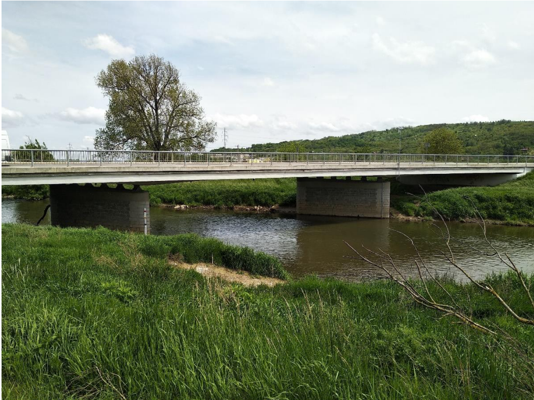
Obr. 12) Boční pohled na most ve Vojkovicích
