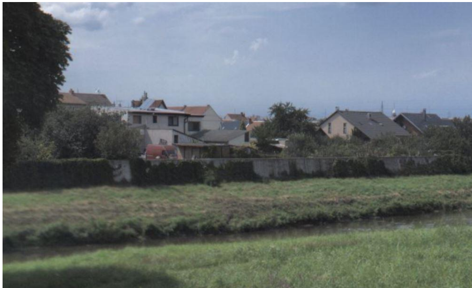
Obr. 18) PPO provedena v roce 2000 [12]
