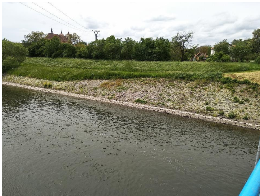
Obr. 13) Opevnění břehu v okolí silničního mostu Rajhradice
