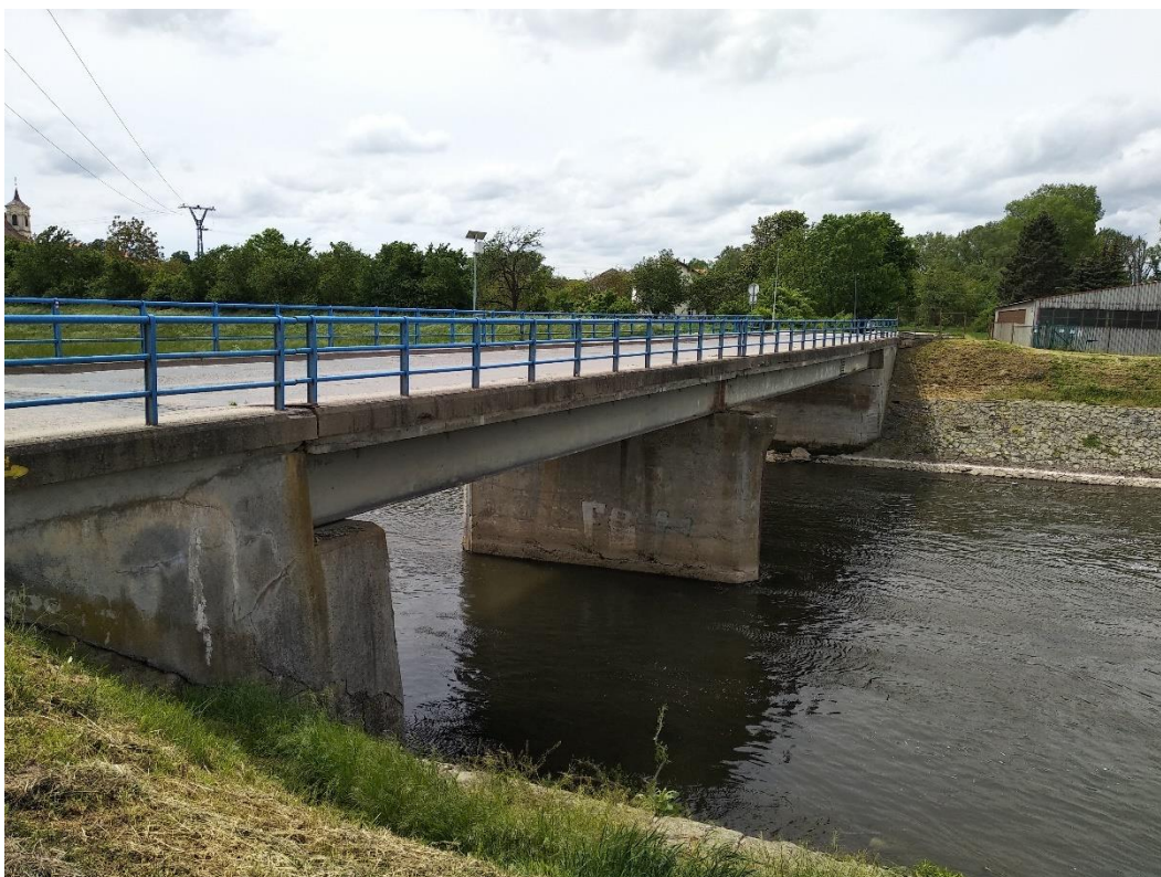
Obr. 10) Pohled na silniční most Rajhradice
