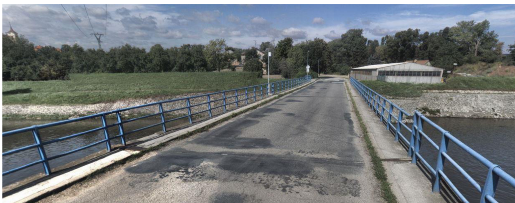
Obr. 11) Silniční most Rajhradice [12]
