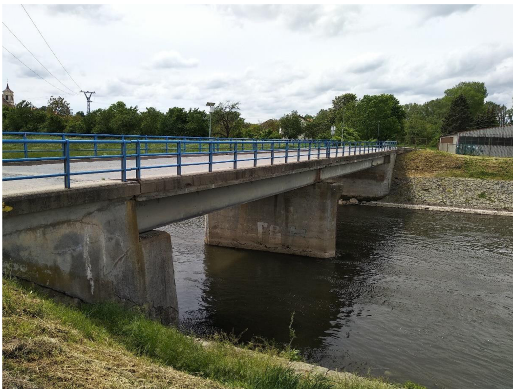
Obr. 10) Pohled na silniční most Rajhradice
