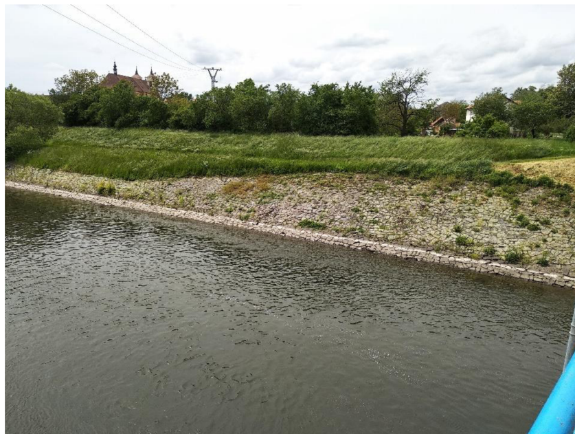
Obr. 13) Opevnění břehu v okolí silničního mostu Rajhradice
