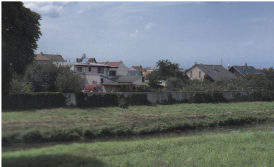
Obr. 18) PPO provedena v roce 2000 [12]
