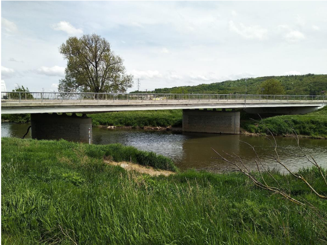
Obr. 12) Boční pohled na most ve Vojkovicích
