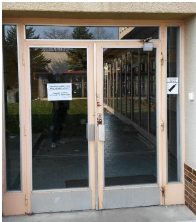
Obrázek č. 15: Hlavní vchod do budovy č. 3
