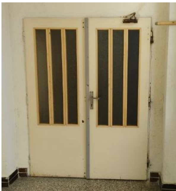
Obrázek č. 14: Vstup ze spojovací chodby do budovy č. 2
