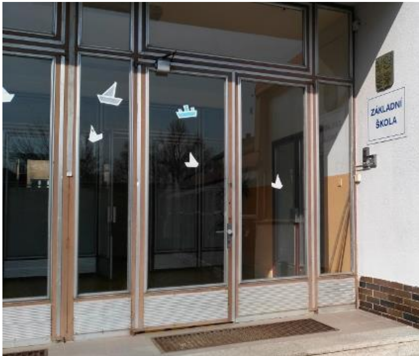
Obrázek č. 12: Hlavní vchod do budovy č. 2
