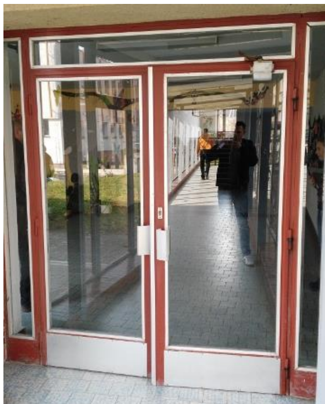
Obrázek č. 16: Vstup ze spojovací chodby do budovy č. 3
