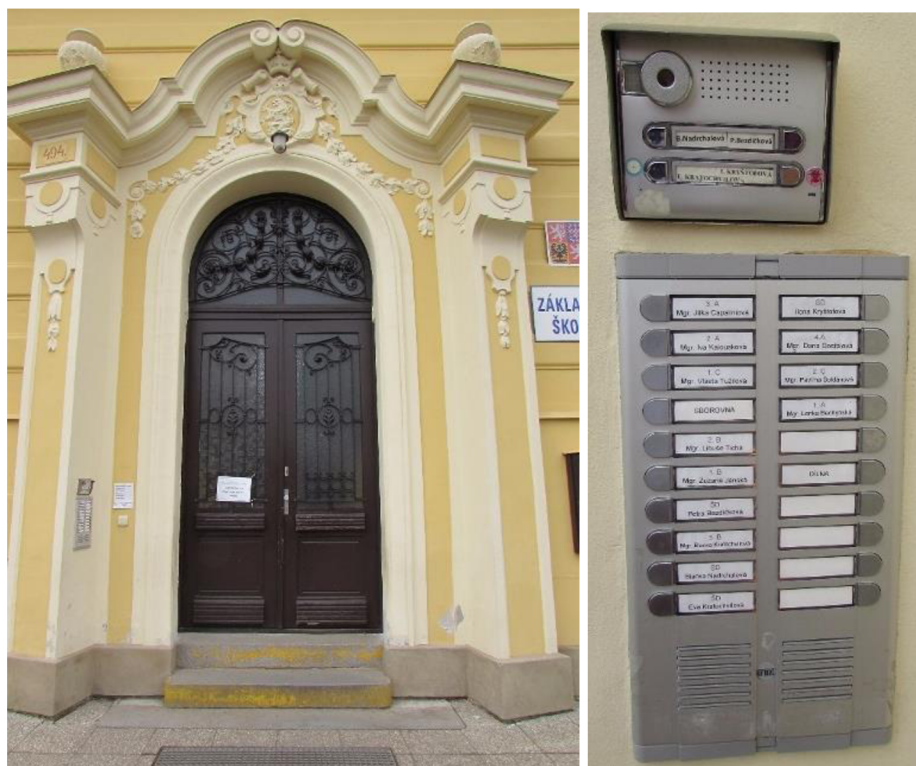
Obrázek č. 11: Vstup a zvonky budovy č. 1
