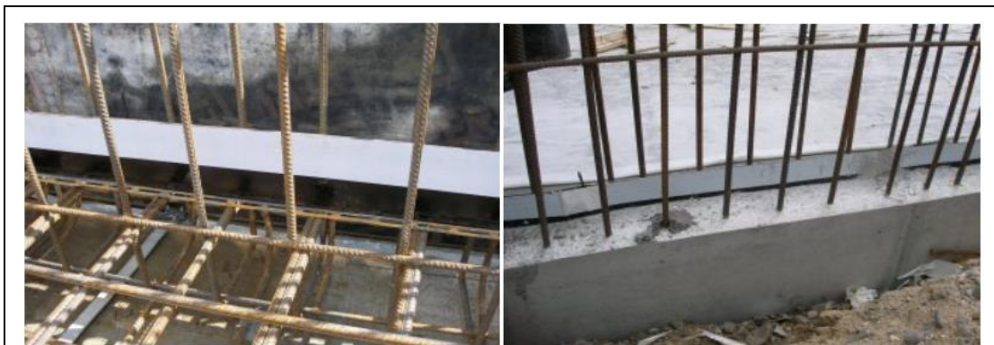
Obrázek 29.: Osazení BK plechu a zabetonování[58]
