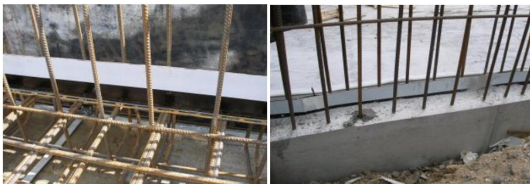
Obrázek 29.: Osazení BK plechu a zabetonování[58]
