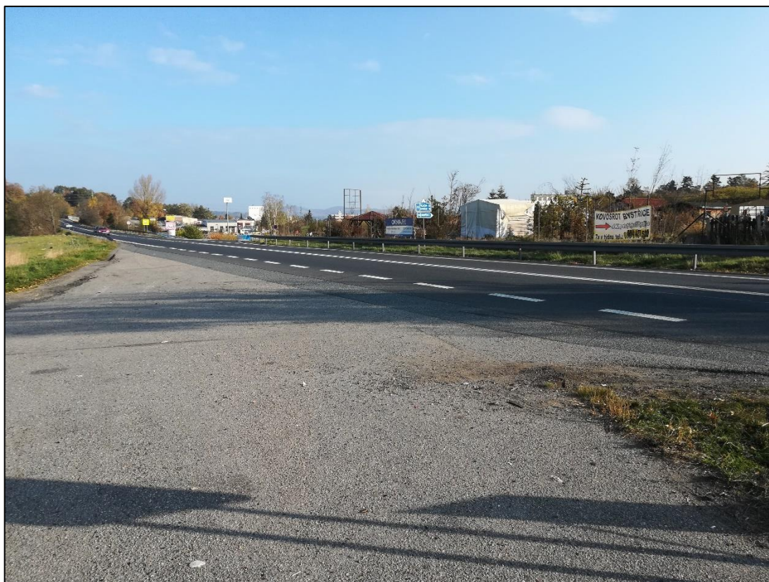
Obrázek 16 - Fotodokumentace, silnice E 55, Benešov
