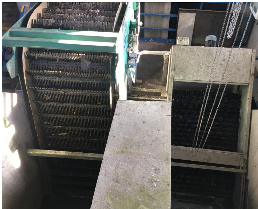
Obrázek 13 - Samočistící česle [zdroj: vlastní pořízení]
