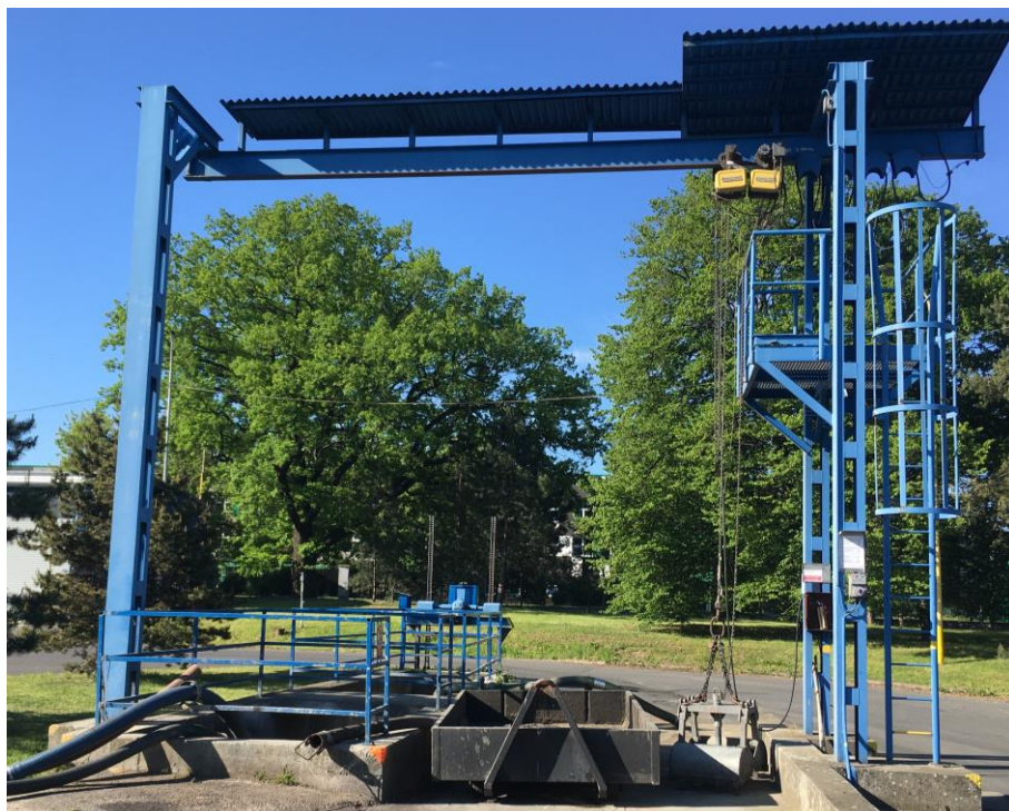
Obrázek 12 - Lapák štěrku [zdroj: vlastní pořízení]
