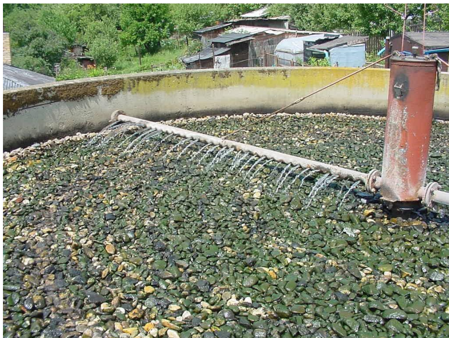
Obrázek 19 – Skrápěný biofilmový reaktor [54]
