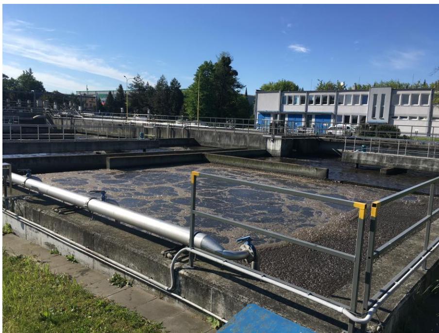
Obrázek 18 - Aktivační nádrž [zdroj: vlastní pořízení]
