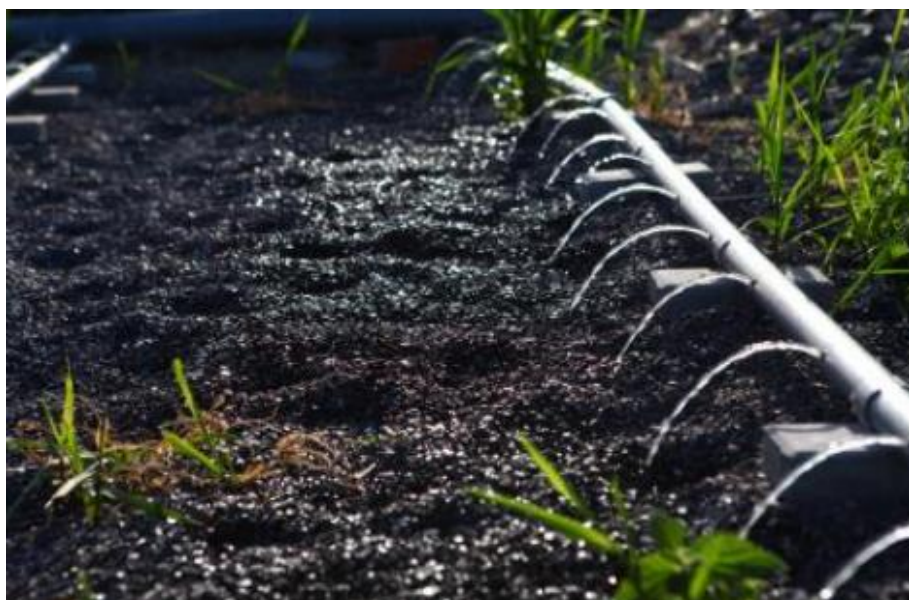
Obrázek 24 - Pulzní skrápění vertikální kořenové čistírny [33]
