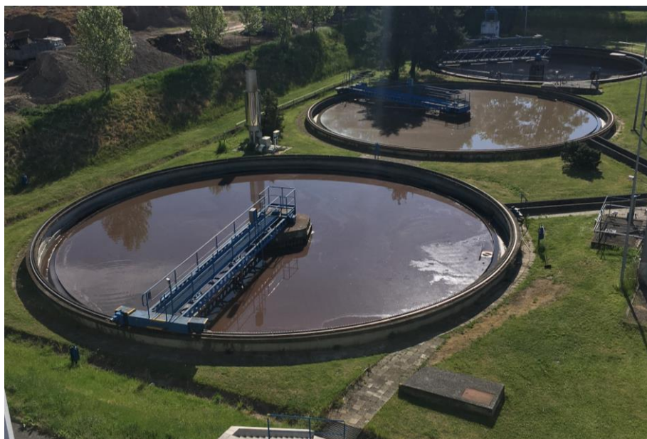
Obrázek 17 - Kruhová usazovací nádrž [zdroj: vlastní pořízení]
