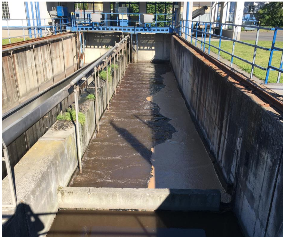
Obrázek 15 - Provzdušňovací lapák písku [zdroj: vlastní pořízení]
