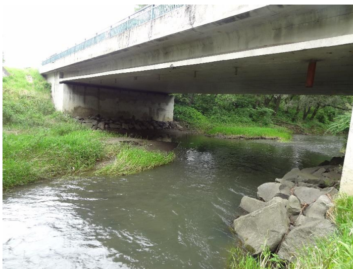
Obrázek 26: Vhodně řešený most pro vydru (Siwková, 2019)
