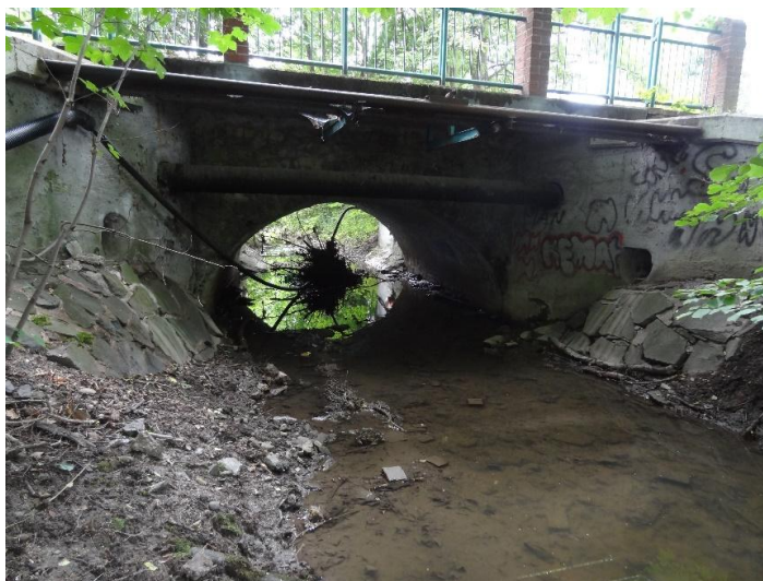
Obrázek 25: Nevhodně řešený most pro vydru (Siwková, 2019)
