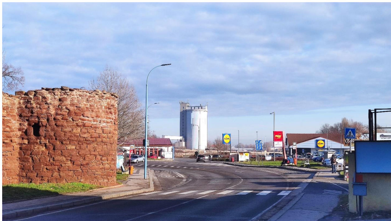
Foto 19 Kontrast dvou dominantních staveb Českého Brodu – středověké hradby a budova cukrovaru ( Jakub Kubásek, 2020 )
