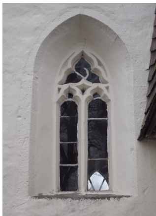
9. Severní okno presbytáře, třetí čtvrtina 13. století, druhé, Tečovice, kostel sv. Jakuba Většího.
