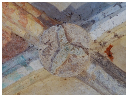
6. Svorník s trojitou ostruhou, třetí čtvrtina 13. století, první pole křížové klenby, Tečovice, kostel sv. Jakuba Většího.
