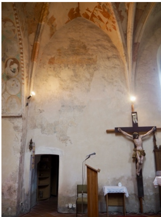
37. Severní stěna presbytáře, 70. léta 14. století (?), nástěnná malba, Tečovice, kostel sv. Jakuba Většího.
