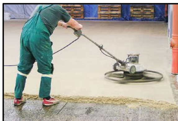
Obrázek 7 Hutnění polymerbetonu [29]
