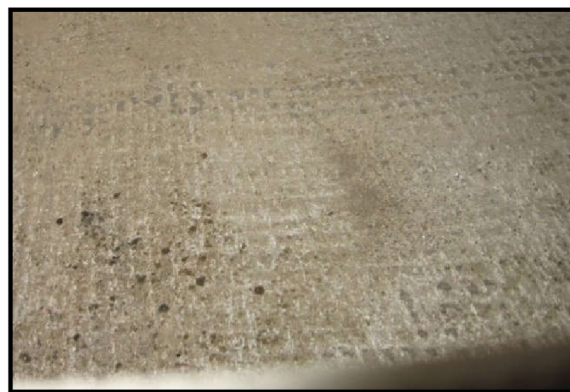
Obrázek 3 Sanovaná betonová deska frézováním [29]
