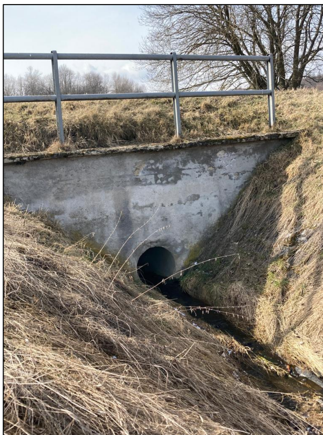
Příloha č. 4: Propustek na silnici 00616.
