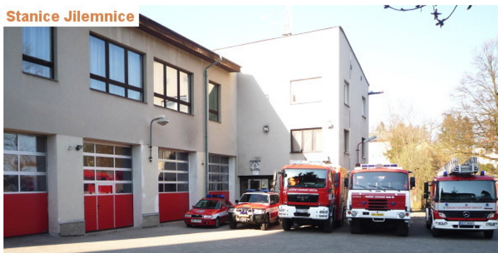
Obrázek č.3: Požární stanice Jilemnice
