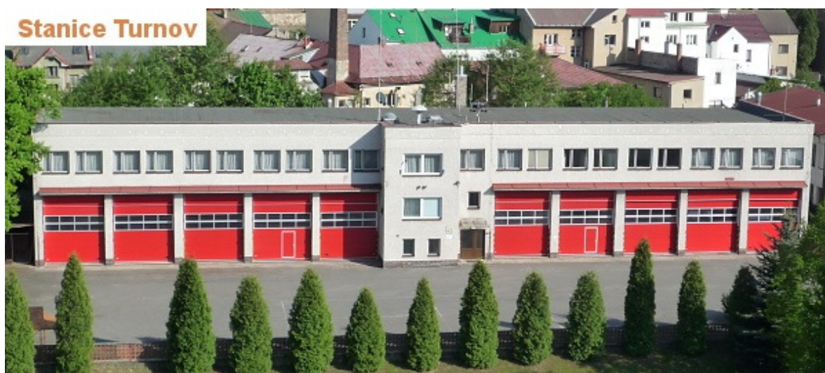
Obrázek č.2: Požární stanice Turnov
