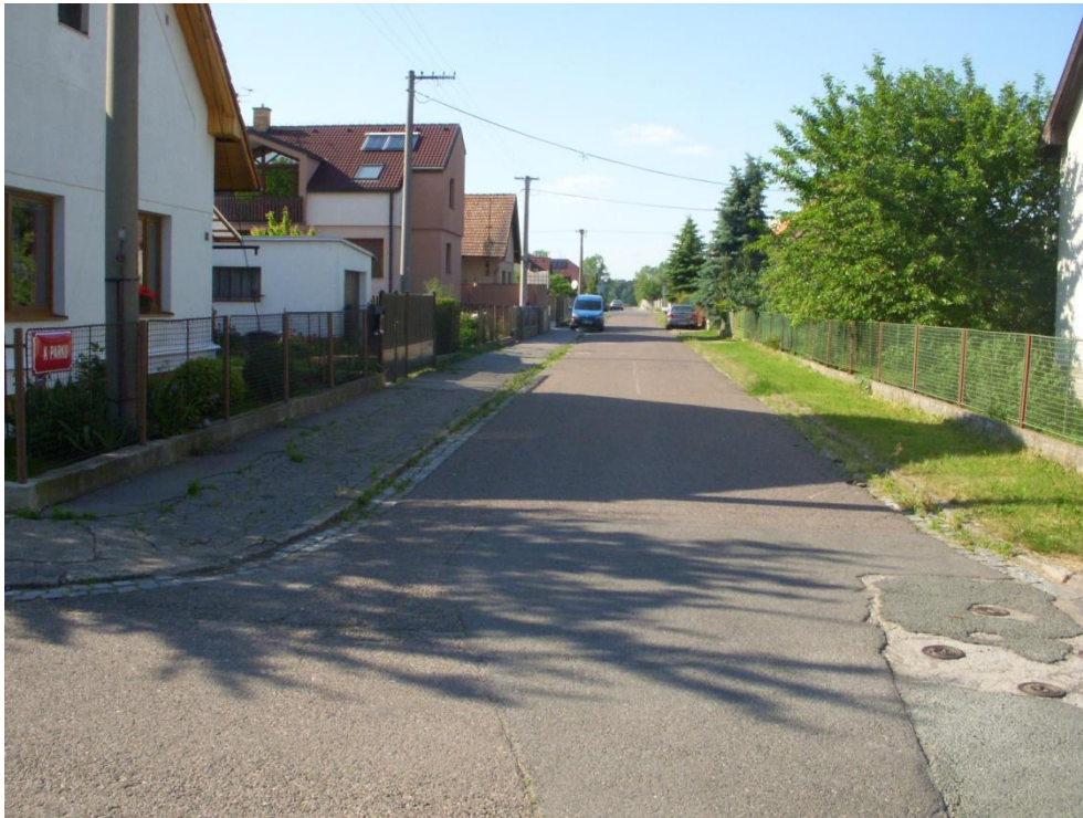
Obrázek 7: Pohled do ul. Závodní směrem k silnici III/0362
