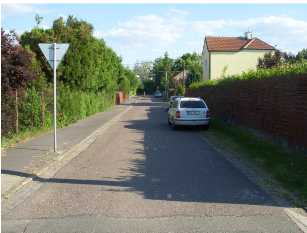
Obrázek 4: Pohled do ul. Brandlova od silnice III/0362
