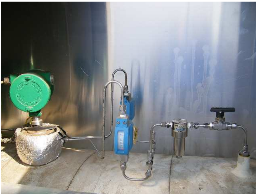
Obr. 12 – Zcela odstraněná izolace
