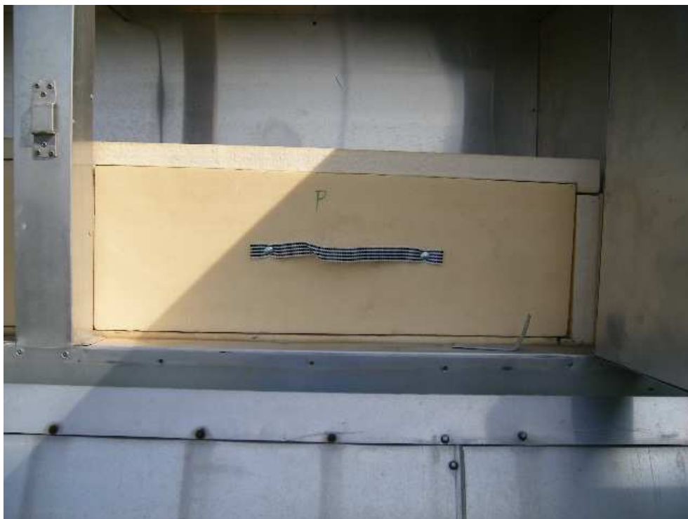
Obr. 10 – Izolace z tvrdých PUR pěnových desek
