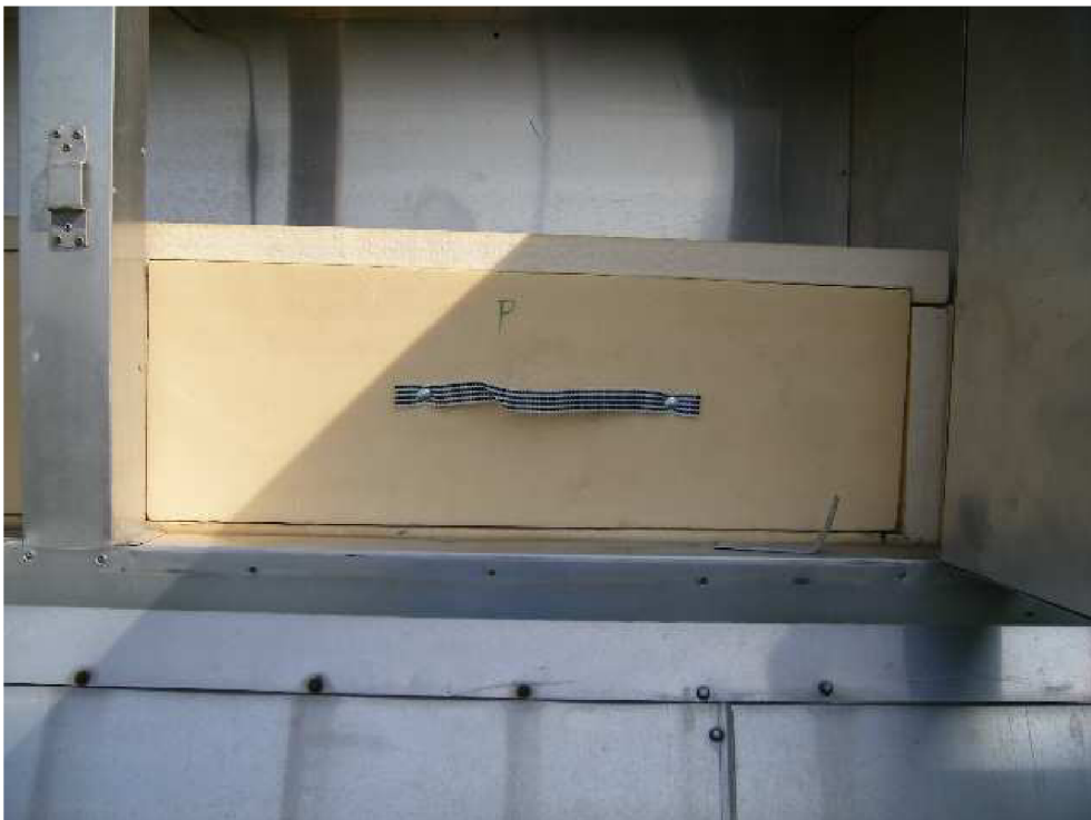
Obr. 10 – Izolace z tvrdých PUR pěnových desek
