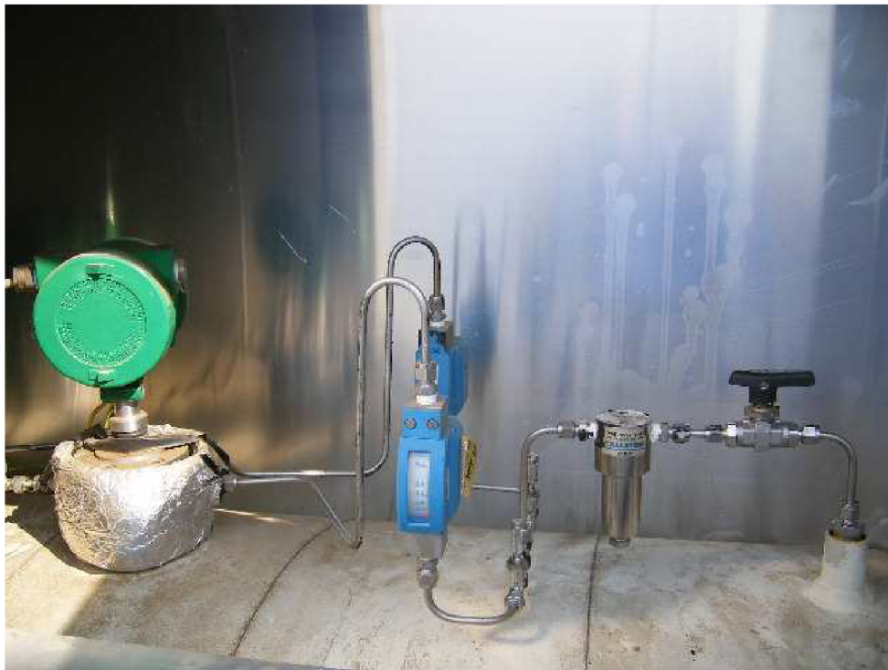
Obr. 12 – Zcela odstraněná izolace
