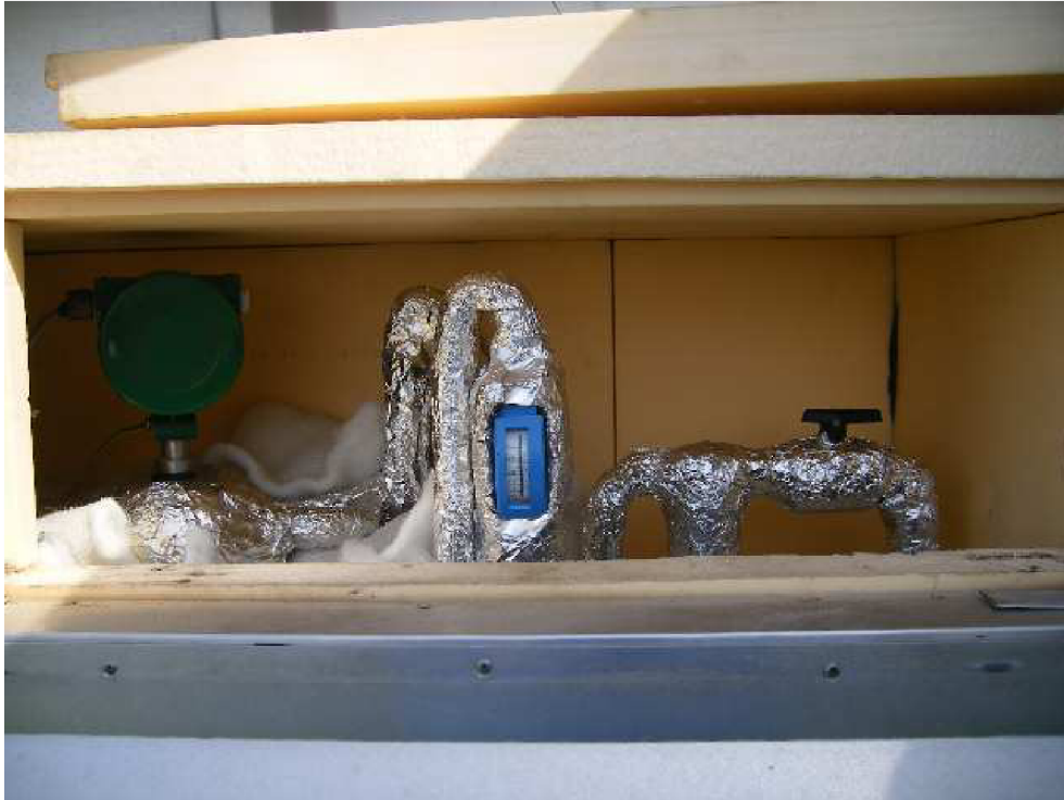
Obr. 11 – Izolace vibračního hustoměru
