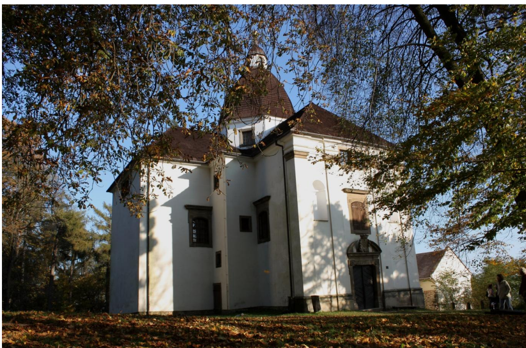
Obrázek 6 Kaple sv. Barbory, 1672-1673, pohled od příjezdové cesty.
