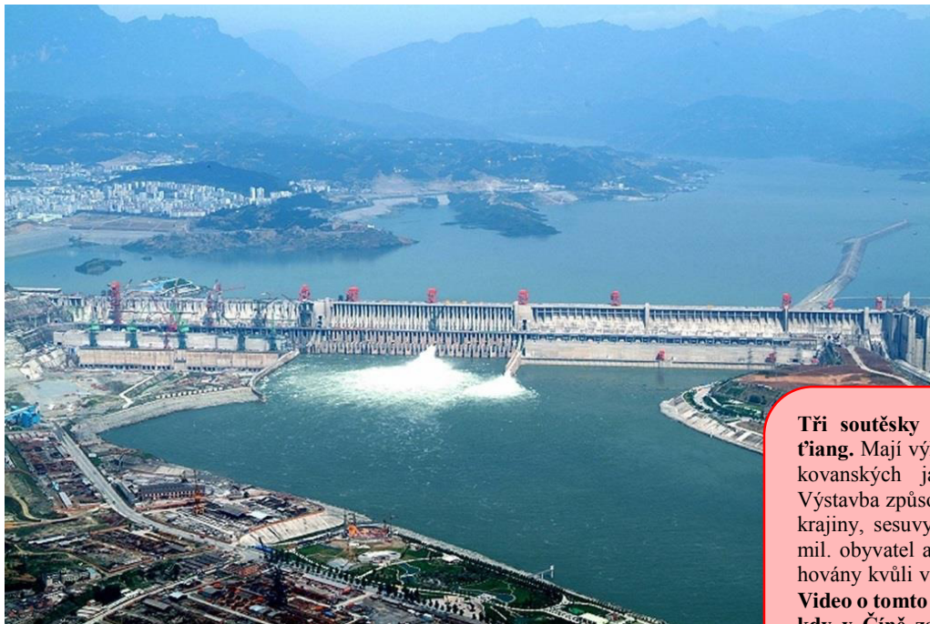
Obr. 6.11: Vodní elektrárna Tři soutěsky. Zdroj: budowle.pl.
