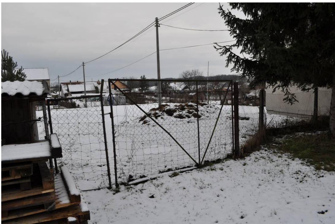
Obr. 23: Pohled na problémový pozemek na rozvojové ploše lokality 25. Patrný je uprostřed pozemku umístěný sloup rozvodu elektrického vedení. Vpravo se nachází budova příležitostné úřadovny.
