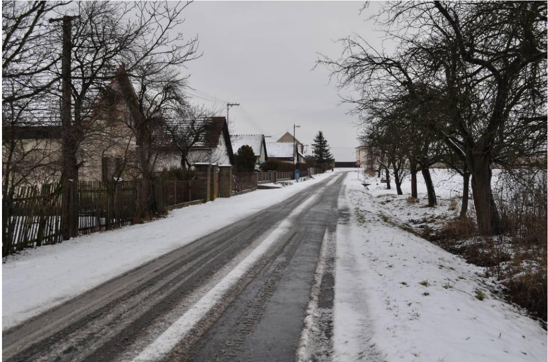
Obr. 7: Silnice III. třídy č. 27524, která tvoří jižní hranici zástavby. Patrná je typická štítová orientace objektů, které v tomto případě pocházejí z 20. a 30. let 20. století.
