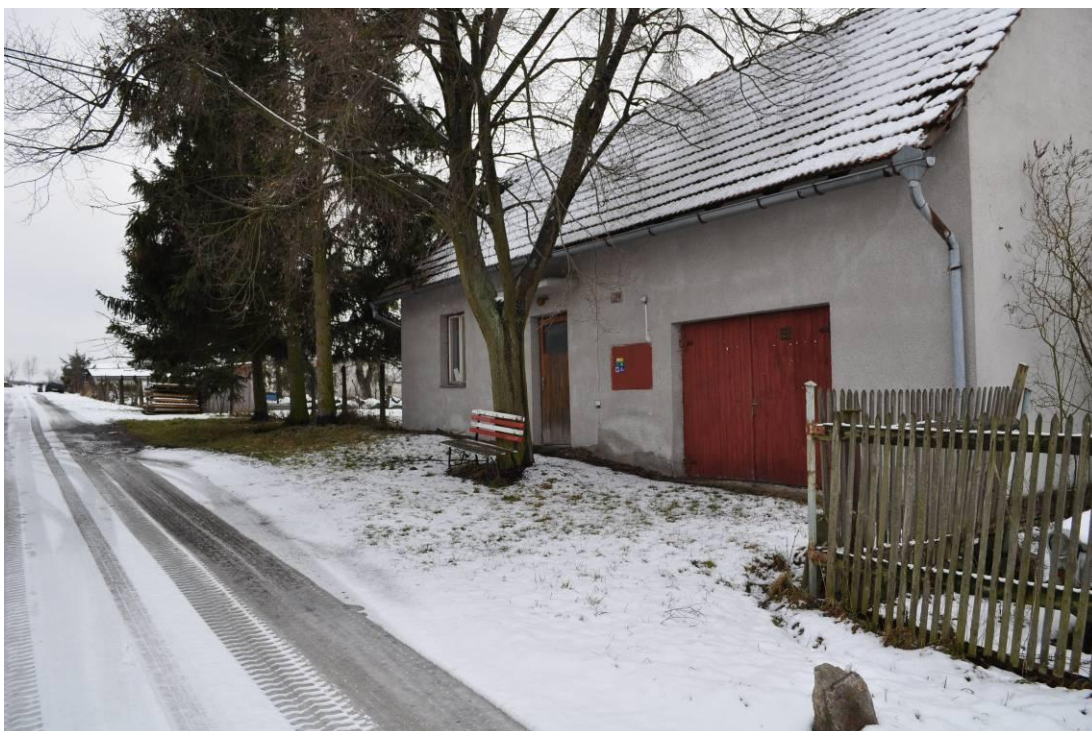
Obr. 17: Objekt příležitostné úřadovny a bývalé požární zbrojnice.
