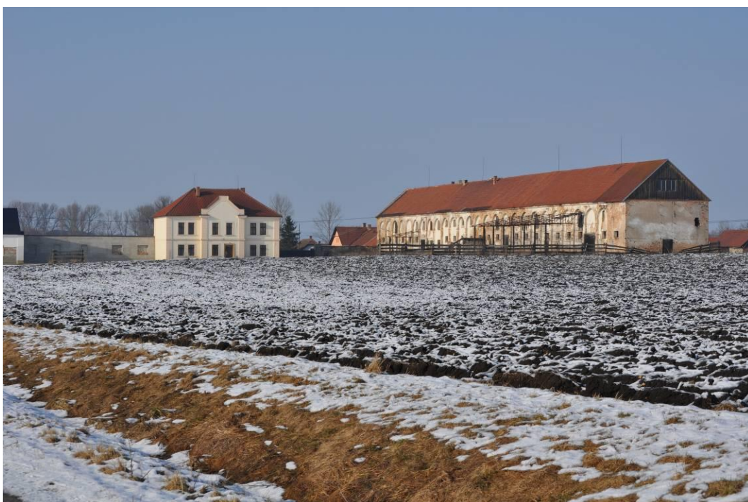
Obr. 16: Pohled na budovy místního dvora, který je největší stavbou v sídle. Pohled od jihozápadu.
