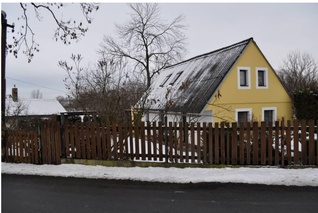
Obr. 18: Jeden z představitelů poválečné výstavby, dům s č. p. 8, který vznikl po zřícení původního objektu v roce 1979.
