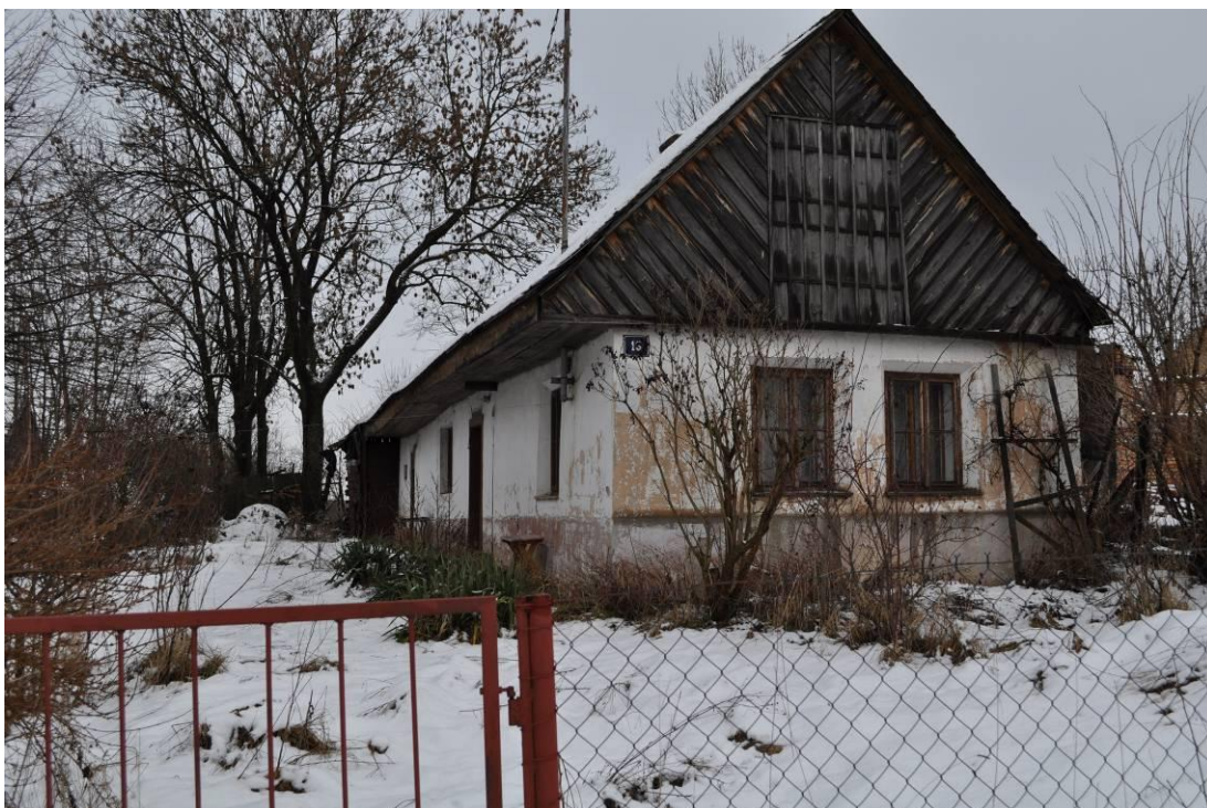
Obr. 13: Dům s č. p. 13. Jeden z objektů, který už byl v rámci stabilního katastru veden jako zděná stavba.
