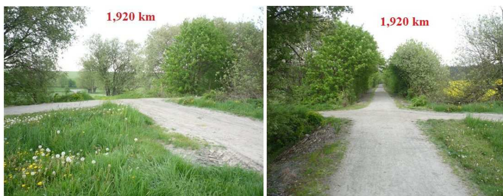
Obr. 39 Pohled na křížení s účelovou komunikací, vpravo ze směru od napojení na I/34 (Zdroj: autor, 2016)
