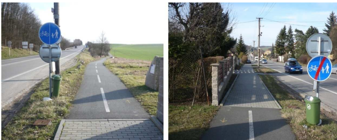
Obr. 26 Stezka pro chodce a cyklisty s odděleným provozem v Lažanech u Brna (Zdroj: autor, 2016)
