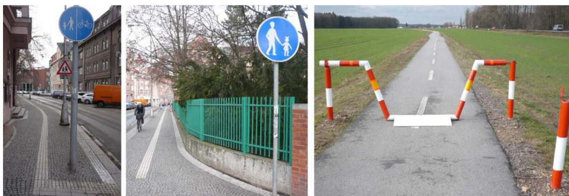
Obr. 30 Nevhodné řešení cyklistické infrastruktury v ulici Šafaříkova v Hradci Králové a brána na cyklostezce u obce Čestice (Zdroj: autor, 2016)
