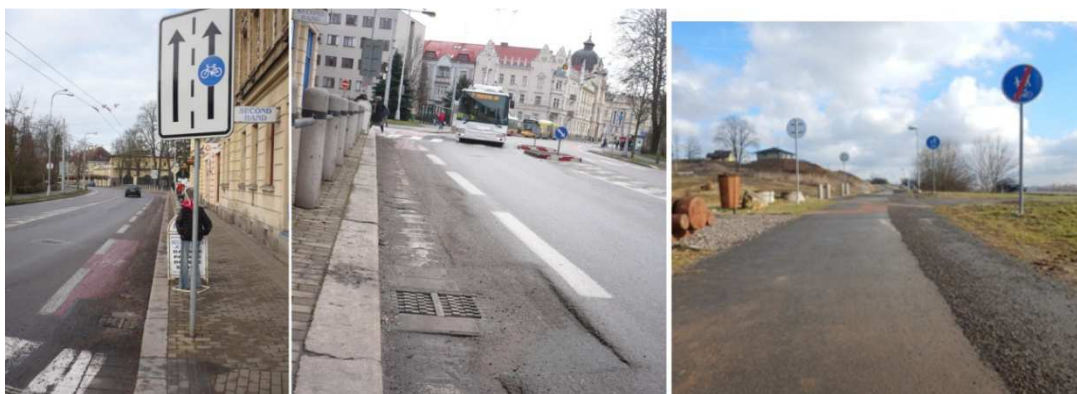
Obr. 31 Špatný stav komunikace a nedostatečná údržba vyhrazeného jízdního pruhu pro cyklisty v Hradci Králové a pouze částečný úklid posypového materiálu na stezce v Rudolticích (Zdroj: autor, 2016)
