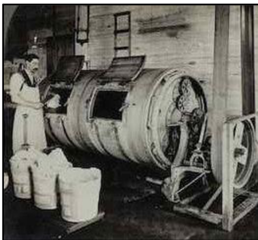
Obrázek 36: Stloukací zařízení – výroba másla.
