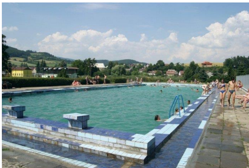
Obrázek 4 - koupaliště před rekonstrukcí
