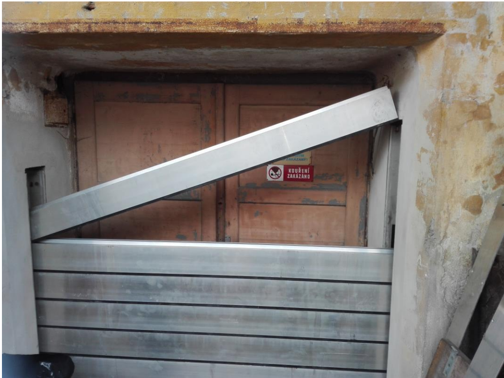
Obrázek 14: Nemožnost vložení posledního hradidla
