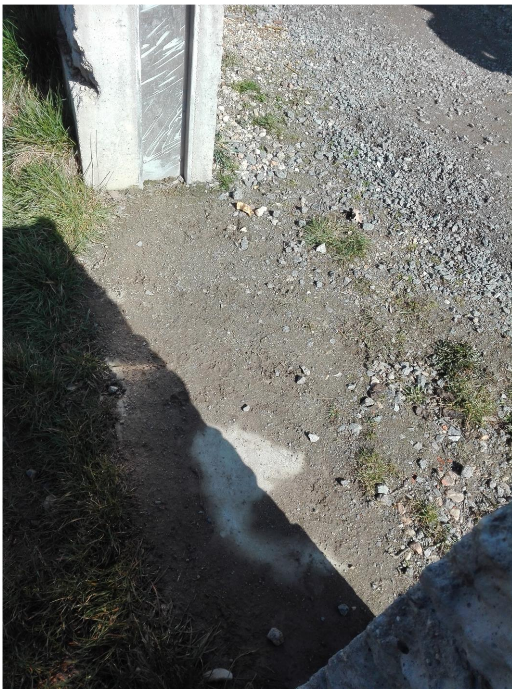
Obrázek 9: Splavený materiál z cesty do prostupu
