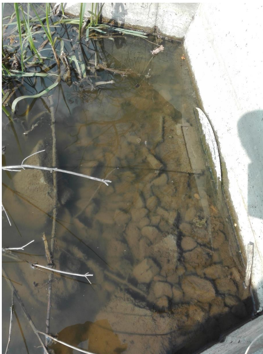
Obrázek 5: Zavalená zpětná klapka
