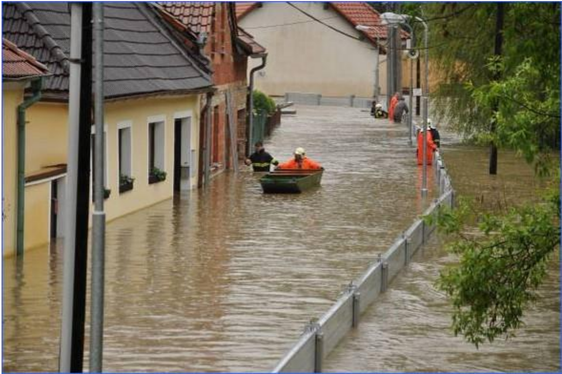
Obrázek 2: Selhání protipovodňových opatření ve městě Bechyně
