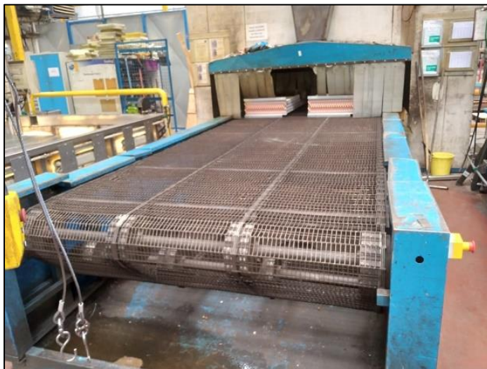
Obr. 21 Sušící pec s pásovým dopravníkem
