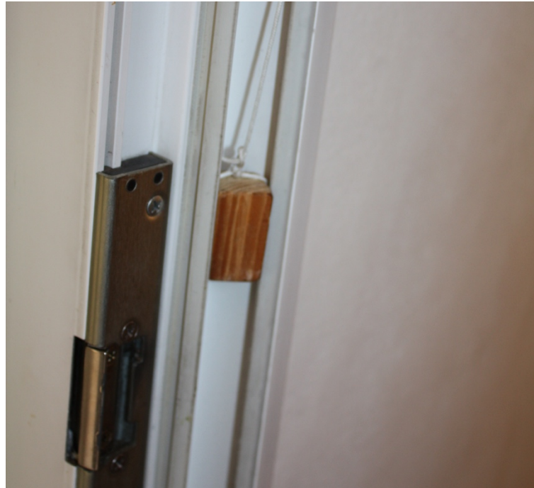
Obr. 17: Klínek v zámku dveří [Zdroj: Vlastní zpracování]
