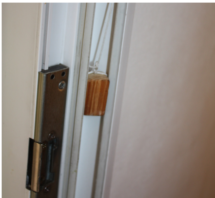
Obr. 17: Klínek v zámku dveří [Zdroj: Vlastní zpracování]
