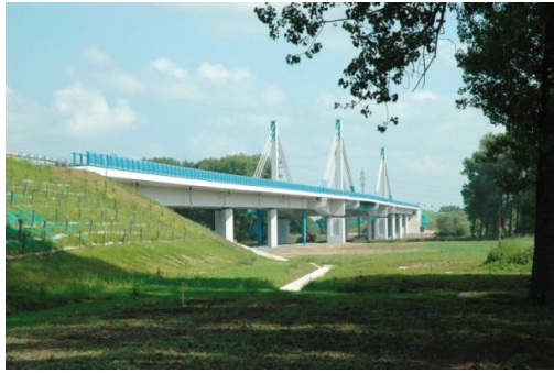
Obr. č. 2: Most přes Labe
