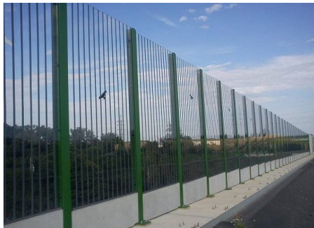
Obr. č. 6: Protihlukové stěny – finální úprava (vlastní foto 2012).
