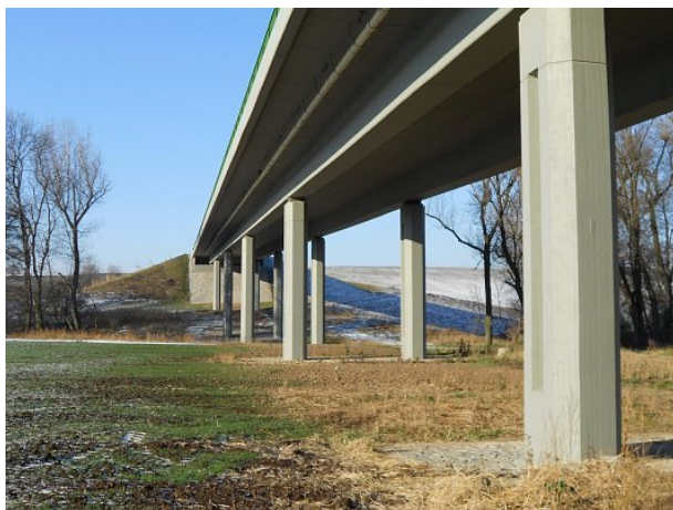
Obr. č. 7: Most přes Polepku a cyklostezku (vlastní foto 2012).
