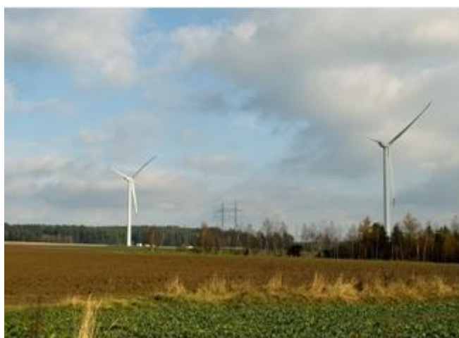
Obrázek 2 Větrné elektrárny Věžnice
