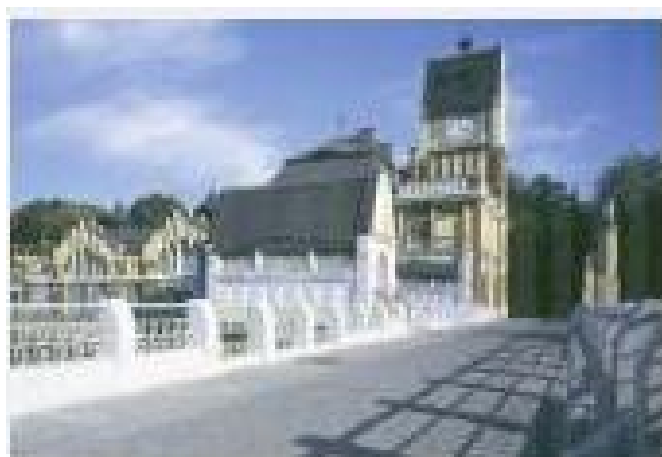
Obrázek 1 Malá vodní elektrárna Hučák Hradec Králové
