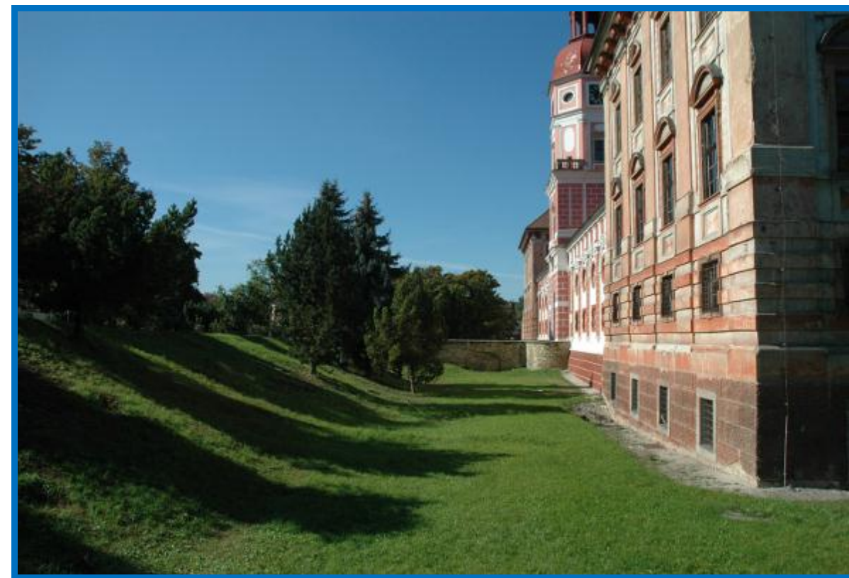
Obrázek 48: Podél jižní a východní strany zámecké budovy je vyhlouben travnatý příkop. Jeho stěny nemají příliš velký sklon, a proto je dobře přístupný. Před jižní stranou zámku je vysazeno několik nevhodných jehličnatých dřevin.
