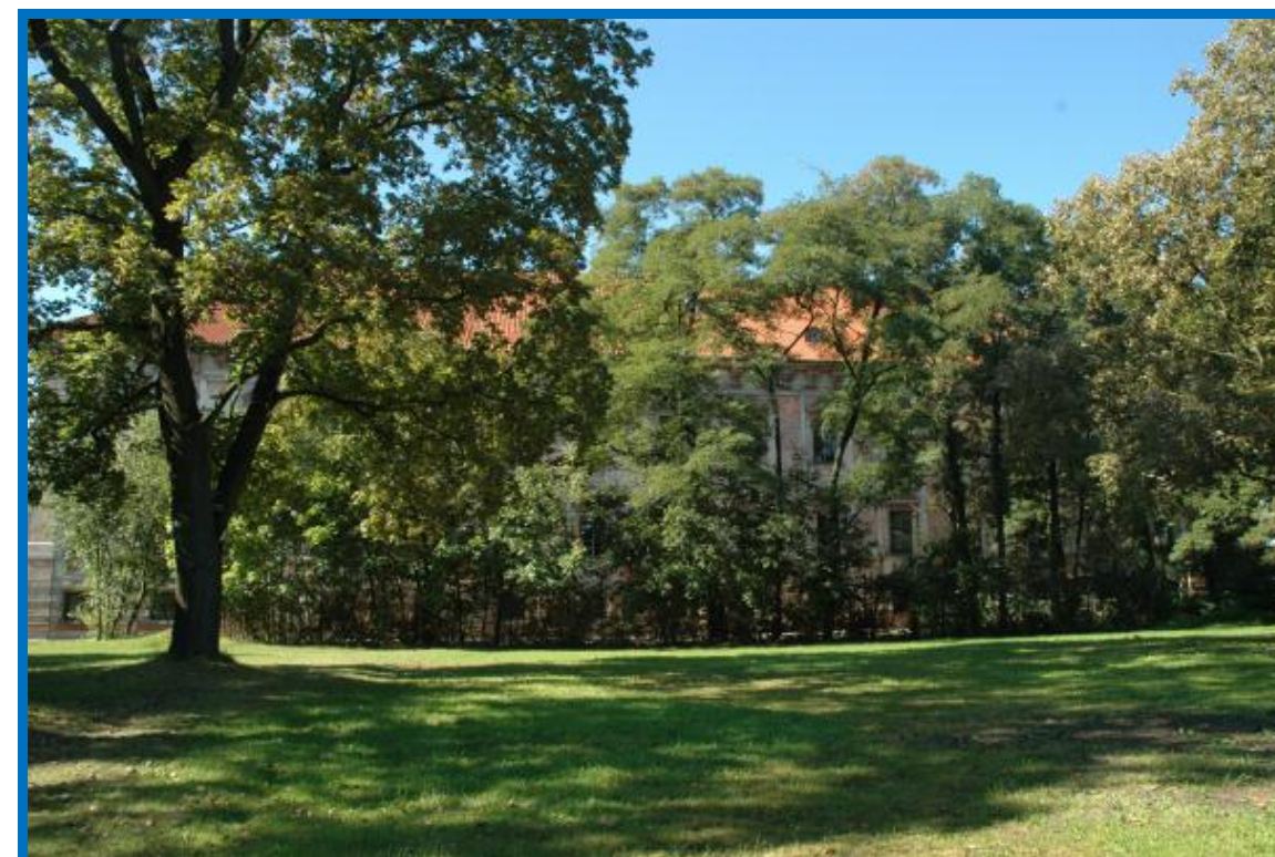
Obrázek 62: Směrem od nádrže je špatně vidět na budovu zámku, protože je zakryt vzrostlými náletovými porosty. Z tohoto důvodu je žádoucí nevhodně rozmístěné dřeviny odstranit, aby byl obnoven pohled na zámek a aby bylo dosaženo efektu zrcadlení zámku ve vodní nádrži.
