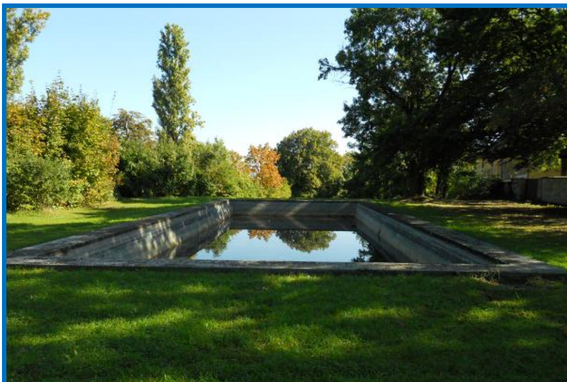
Obrázek 61: V betonové nádrži se soustřeďuje pouze dešťová voda. Nádrž je v dobrém stavu, ale její hluboké dno by mohlo být nebezpečné, proto by bylo vhodné ho zvýšit.
