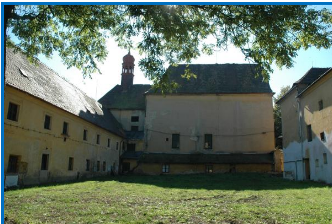
Obrázek 65: Mezi obytnou budovou, kostelem a klášterem je prázdná trávníková plocha. V těchto místech dříve stála jedna z hospodářských budov.
