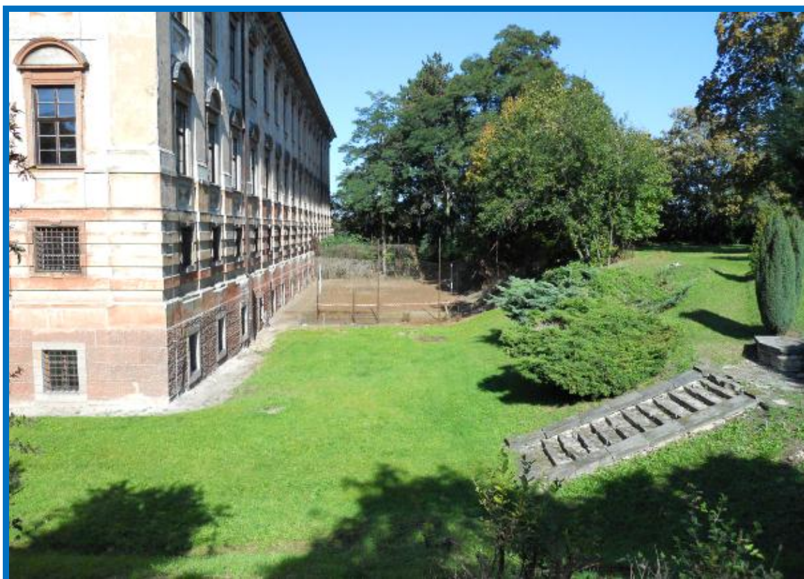
Obrázek 52: K východní straně zámecké budovy přiléhá zanedbané tenisové hřiště, které zde vzniklo v době, kdy na zámku pobývala vojenská konzervatoř. Přístup do travnatého příkopu usnadňují betonové schody.
