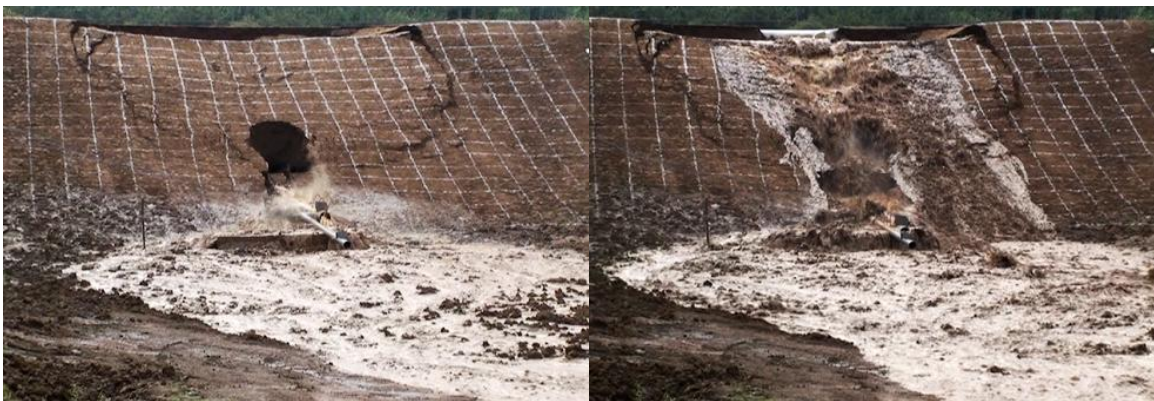
Obr. 1.3. Porušení hráze vnitřní erozí (piping) [8]
