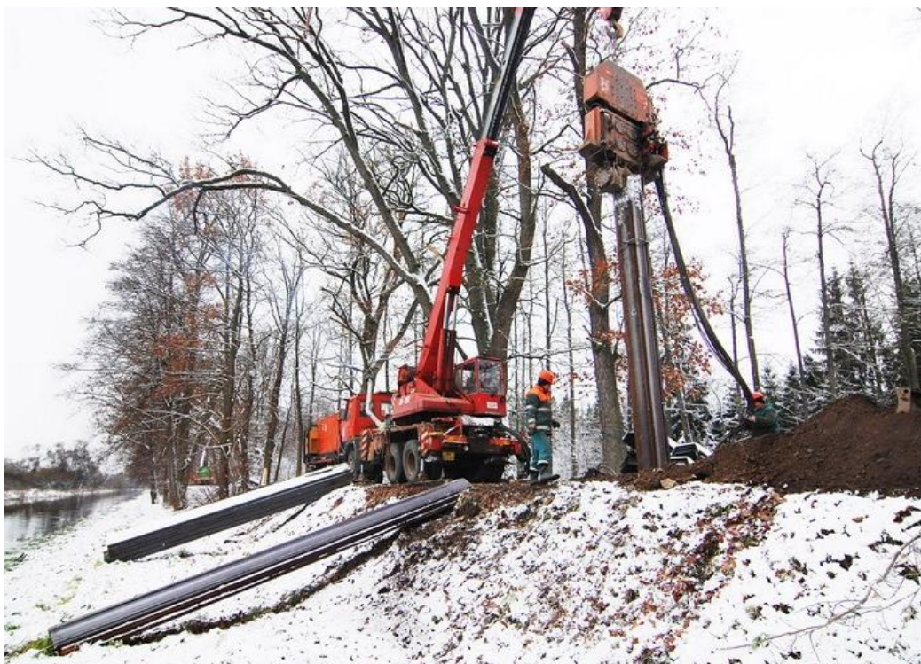
Obr. 4.5. Beranění štětovnice, dotěsnění hráze vodního kanálu Nová řeka [29]
