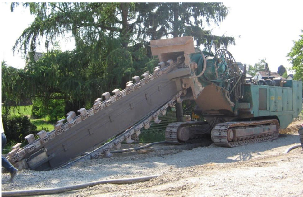
Obr. 4.4. Zařízení k promíchání a injektování zeminy v ochranné hrázi [22]
