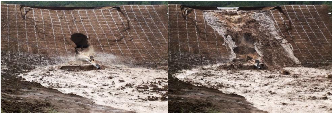
Obr. 1.3. Porušení hráze vnitřní erozí (piping) [8]
