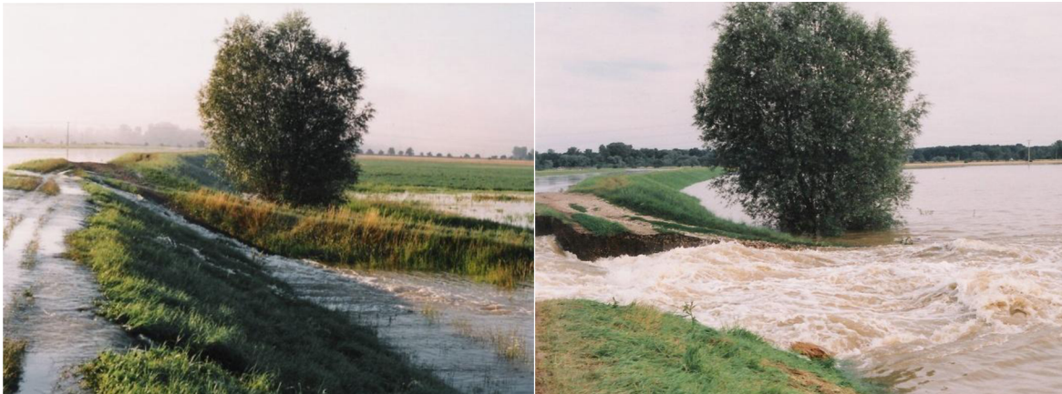
Obr. 1.2 Protržení hráze v důsledku přelití, Lužice povodeň 1997 [13]
