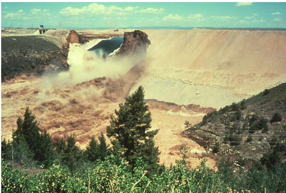
Obr. 1.5. Protržení hráze Teton poblíž Rexburg, Idaho 1976 [10]
