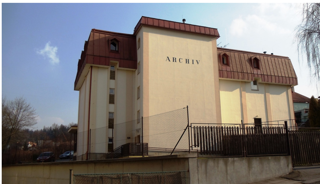
Obr. 2 Budova SOkA Trutnov. Foto: Bc. Luděk Švadlena, 21. 3. 2015
