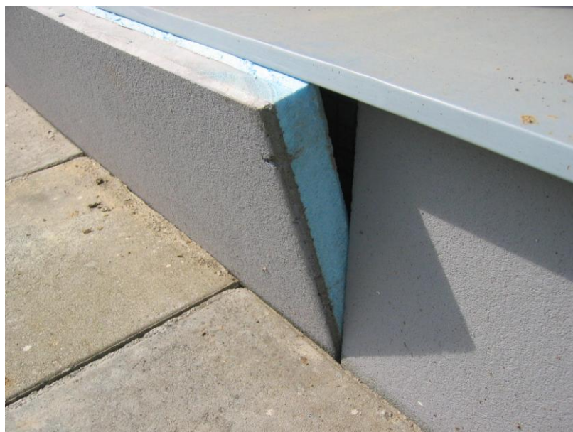
Obrázek č.6 - Zateplení soklové části (9)
