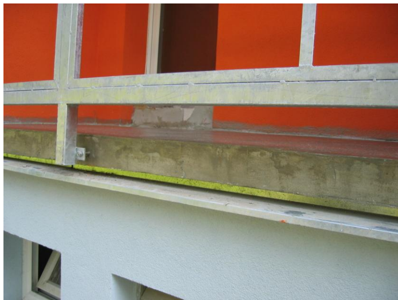
Obrázek č.8 - Nové ocelové zábradlí (9)
