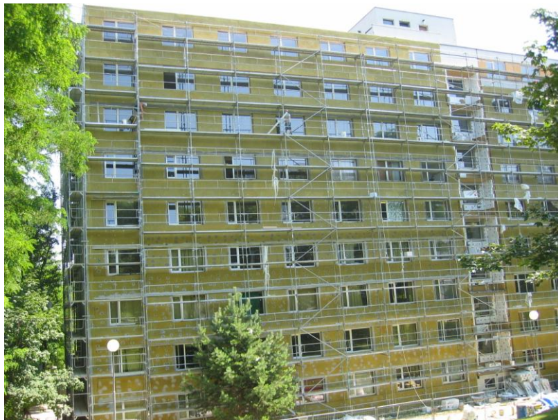
Obrázek č.3 - Pohled na fasádu v průběhu zateplování (9)
