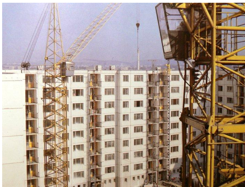
Obrázek č.1 - Výstavba panelových domů, rok 1985, místo Prešov, Slovenská republika
