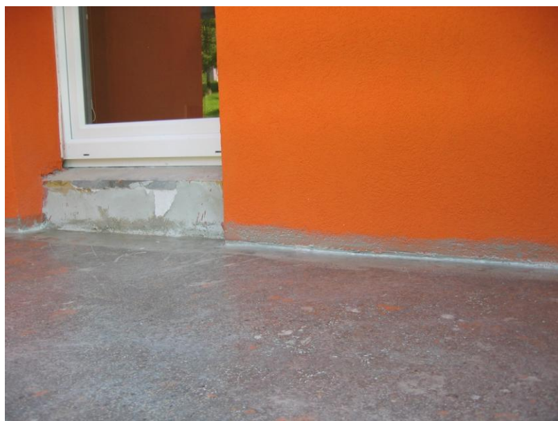
Obrázek č.9 - Hydroizolační stěrka povrchů balkonů (9)
