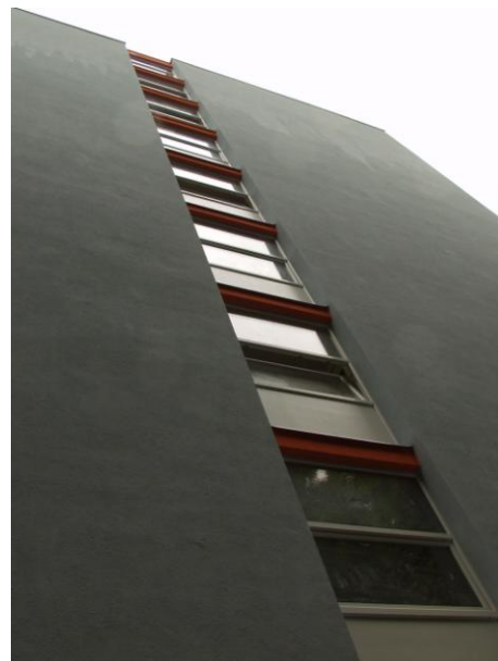
Obrázek č.5 - Nová copillitová stěna (9)
