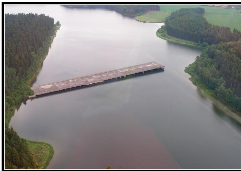
Obrázek č.2 - Příklad špatné investice, nedokončený most Hulice
