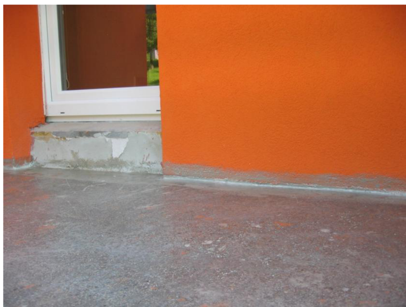
Obrázek č.9 - Hydroizolační stěrka povrchů balkonů (9)
