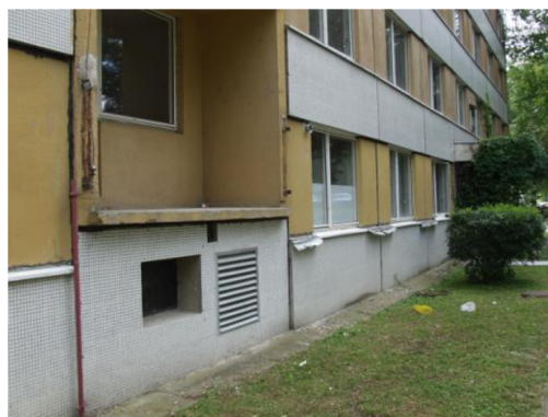
Obrázek č.12 – Nezateplená fasáda (9) Obrázek č.13 – Stav po rek. (9)
