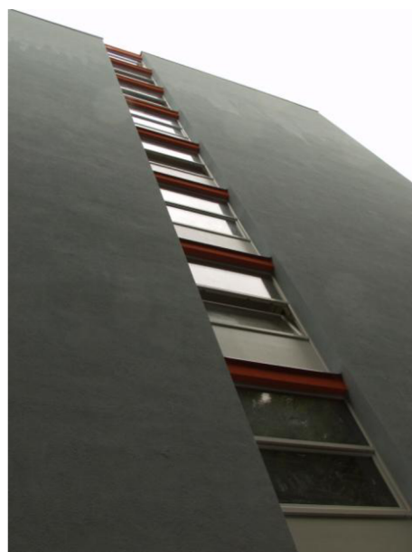
Obrázek č.5 - Nová copillitová stěna (9)
