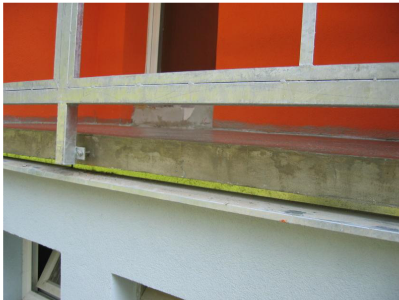
Obrázek č.8 - Nové ocelové zábradlí (9)
