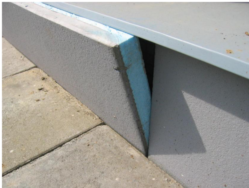
Obrázek č.6 - Zateplení soklové části (9)
