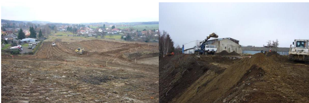
Obrázek č. 8 a 9 Hrubé terénní úpravy v prostoru odvalu a bývalé úpravny - listopad 2012 (bhsanace.správcestavby.cz)
