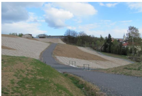
Po provedení sanace duben 2014
