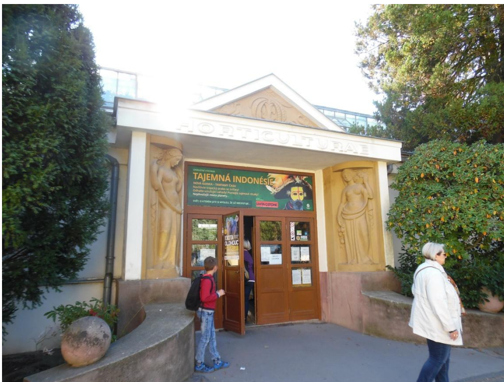
Obrázek 45: Julius Fučík, Sochařská výzdoba vchodu do Palmového skleníku, Smetanovy sady, 1927–1930 (fotografie z roku 2018).
