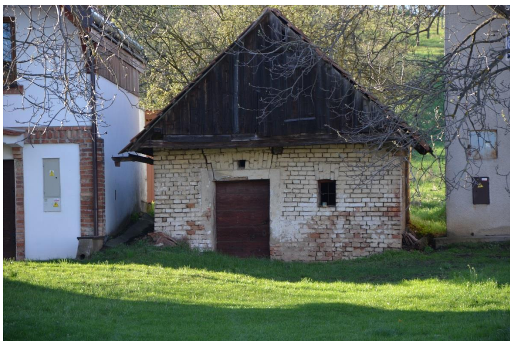
Obrázek 76: Sklep s přízemní lisovnou, areál vinohradnických staveb, Vlkoš
