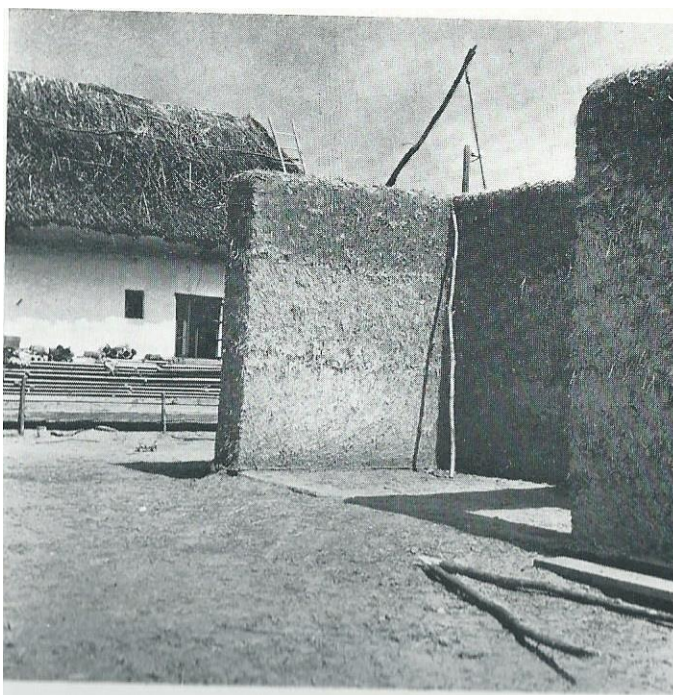
Obrázek 3: Zed' vzniklá nabíjenou technikou
