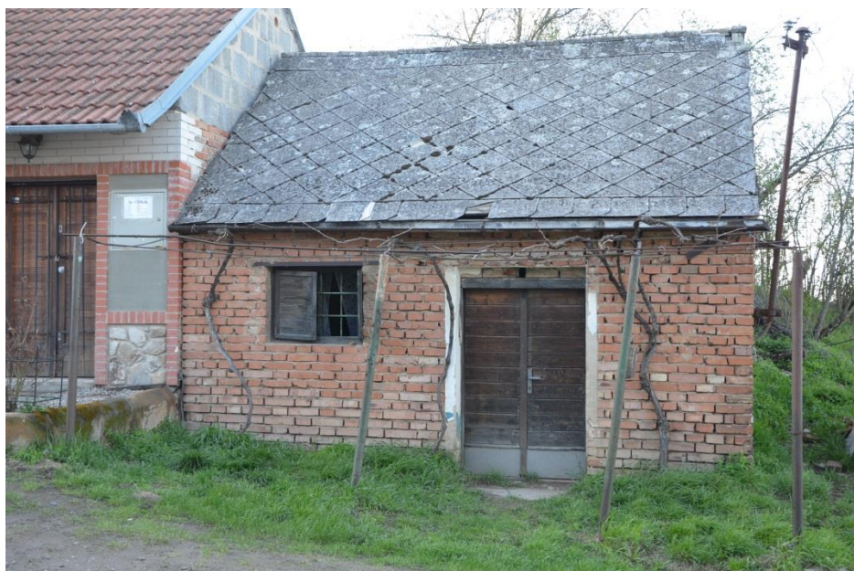
Obrázek 40: Přízemní sklep s lisovnou s typickým malým okýnkem krytým mříží a dřevěnou okenicí, Šidleny, Milotice
