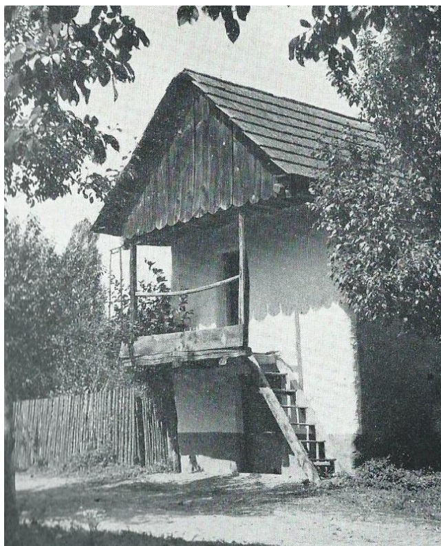
Obrázek 19: Samostatně stojící patrová stodola orientovaná do ulice
