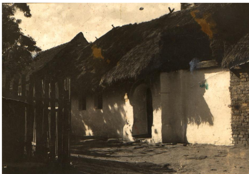
Obrázek 48: Rolnický domek Holečků čp. 124, s doškovou střechou a žúdem, Ratíškovice, ul. U Radnice, dnes neexistuje
