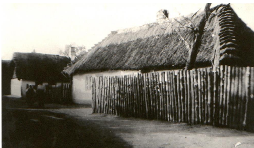
Obrázek 10: Příklad doškové střechy na domě v Ratíškovicích
