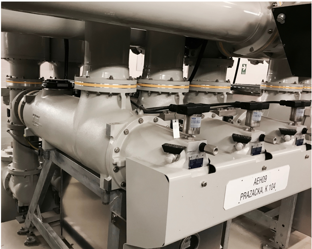
Obrázek 6: Vypínač 110 kV se zhášecím plynem SF 6
