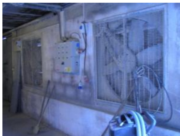
Obr. 3 Štítové ventilátory
