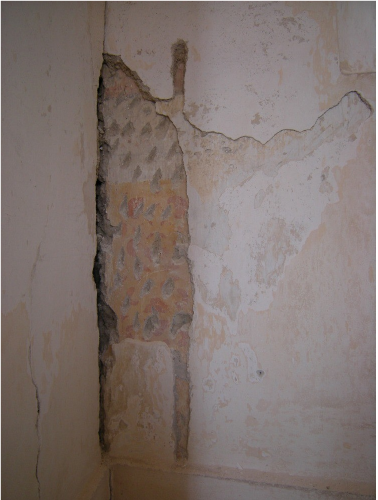
Obrázek 35: Pňovay, odkryté gotické malby, foto autor
