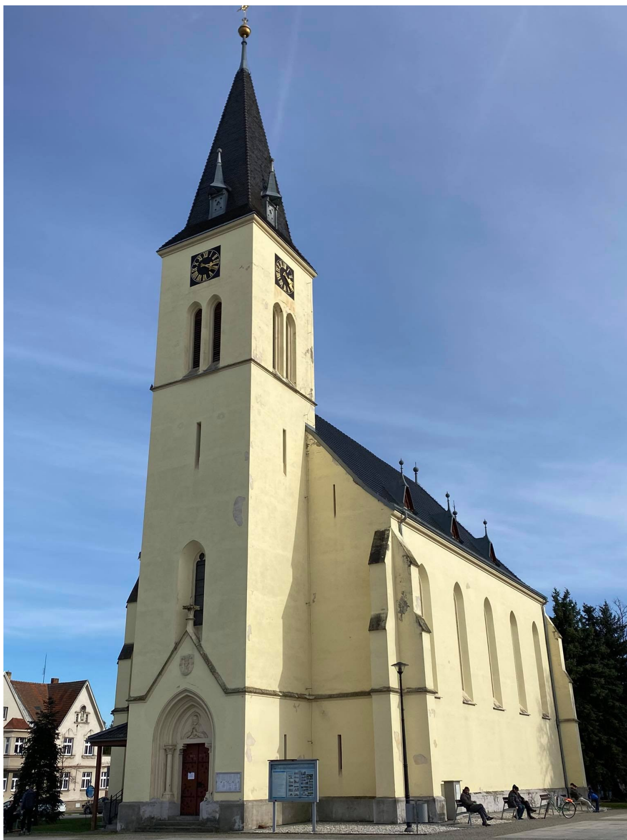
Obrázek 22: Kostel sv. Prokopa, Nýřany, foto autor
