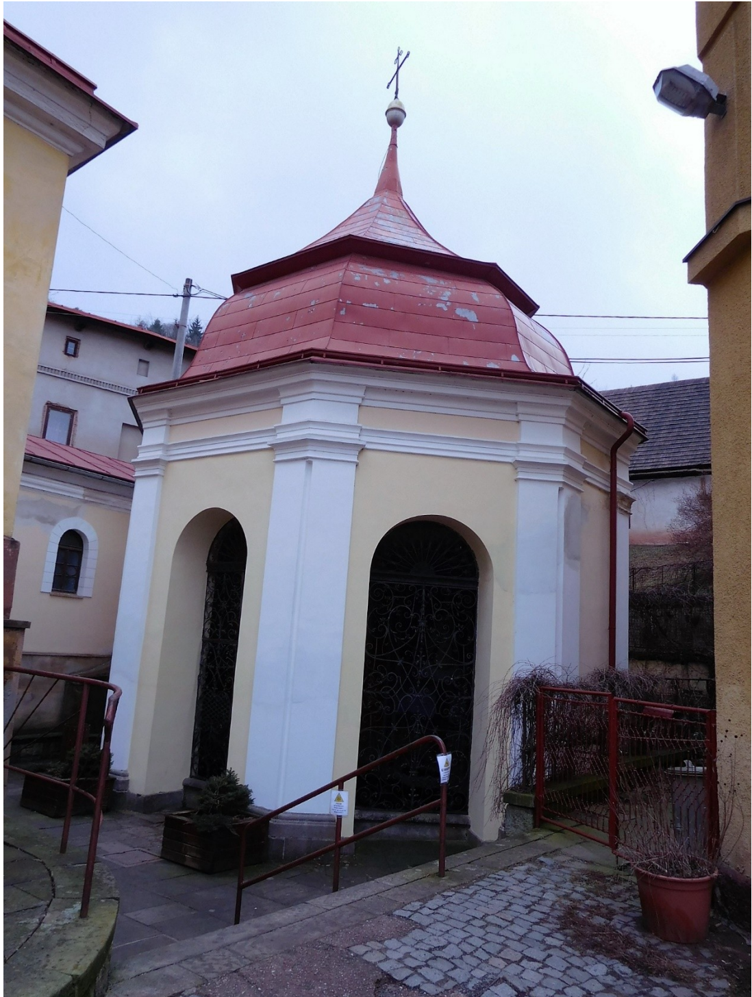
Kaple s vyvěrající léčivou vodou v Malých Svatoňovicích. Fotografie/autor práce.
